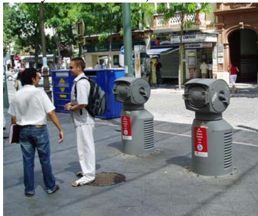
Abb. 2: Mögliche Einwurflösung für pneumatisches Sammelsystem (Quelle: Intecus)
