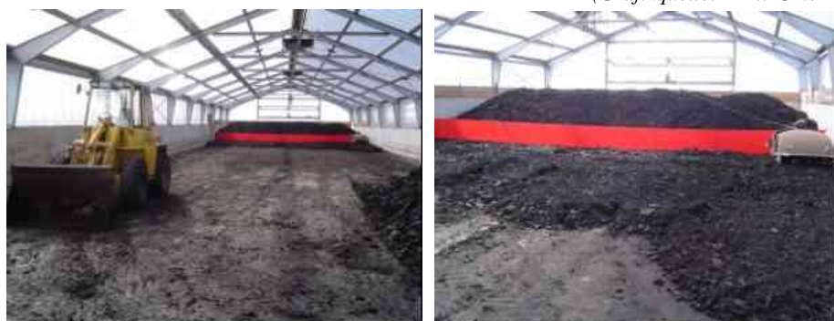
Abb. 2: Solare Trocknungsanlage in Bredstedt
