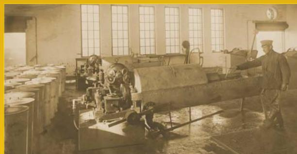
*Bürstenwaschmaschine für das Wechseltonnensystem
