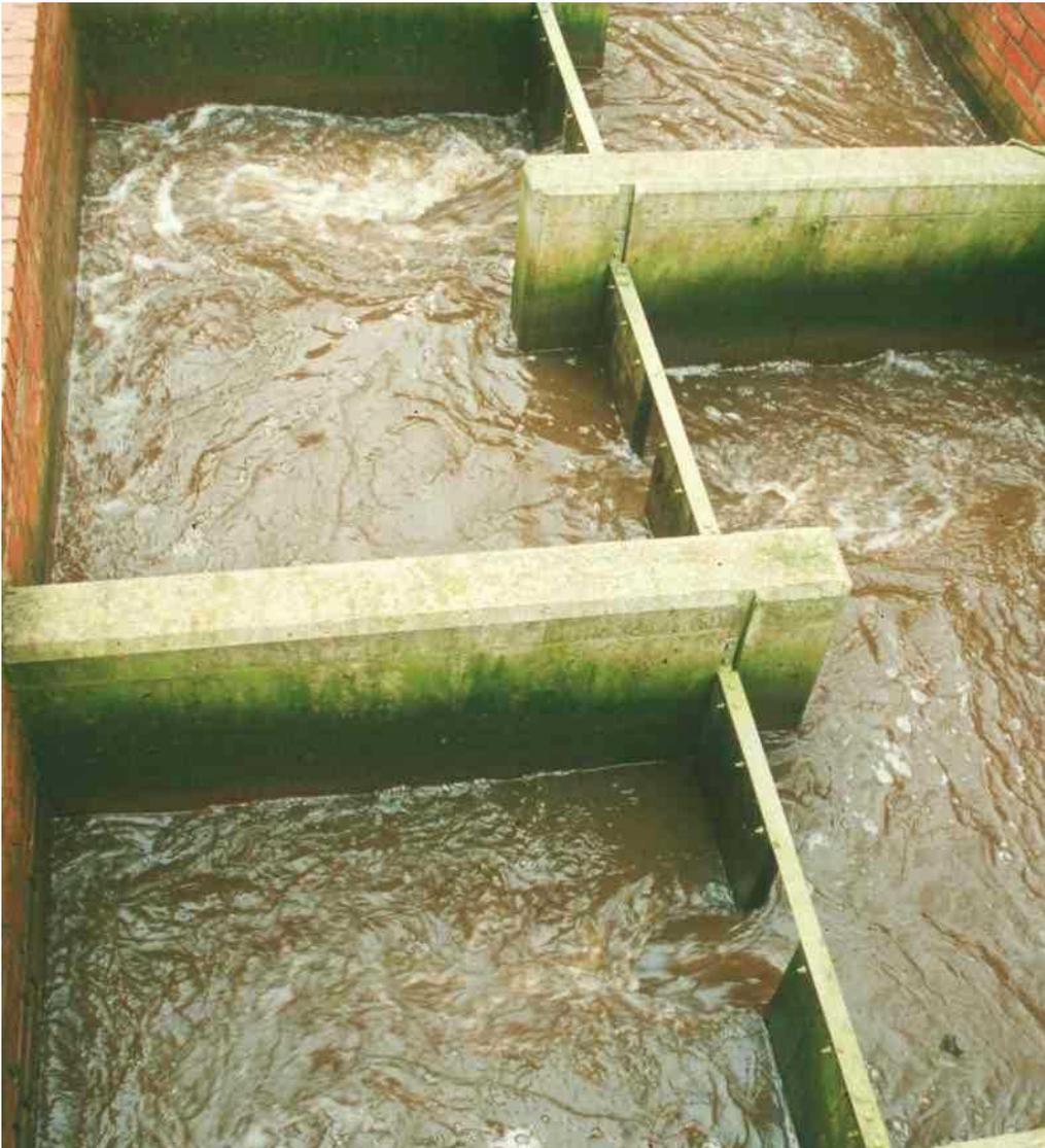
Abb. B.29: Kompakte Ausführung eines Schlitzpass ähnlichen Beckenpasses. Die hydraulische Berechnung kann nicht standardmäßig erfolgen (Heiligenrode, Brandenburg).
