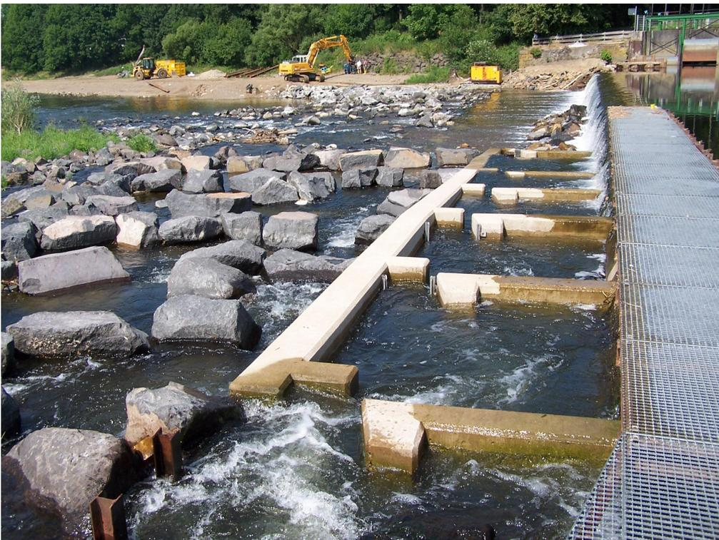
Abb. B.24 Fischaufstiegsanlage (Buisdorf/Sieg, NRW), nachträglich installierter Vertical Slot Pass in der seitlichen Verschneidung (Quelle: Nemitz).
