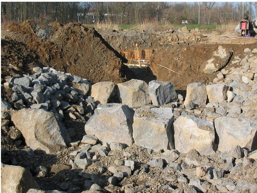
Abb. B.35: Gestaltung der rauhen Sohle innerhalb eines mit Steinblöcken begrenzten Beckens während der Bauzeit.
