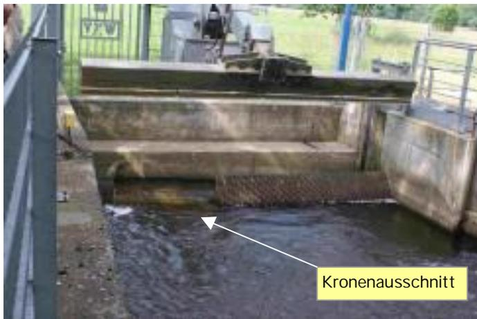
Abb. 7.6: Rechenanlage mit Kronenausschnitt, lichter Stababstand des Vertikalrechens: 10 mm (Quelle: BLASEL, 2010)
