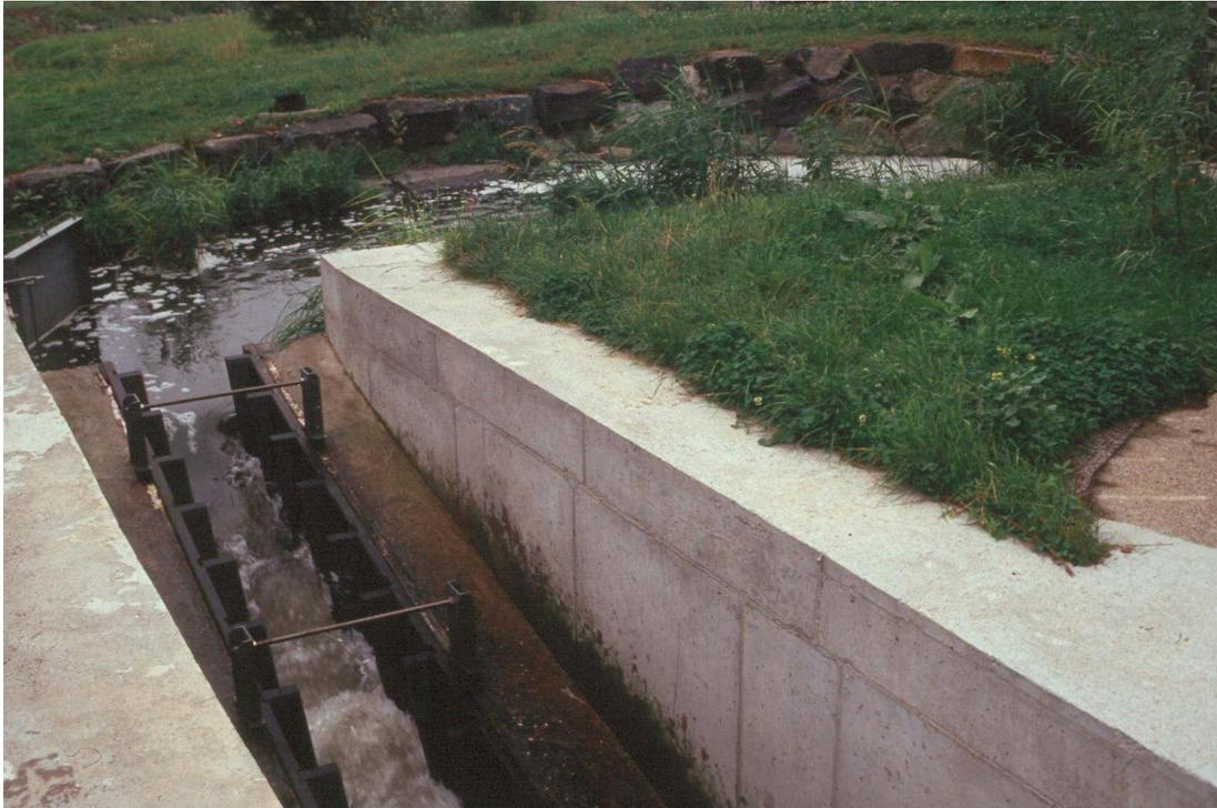
Abb. B.30: Denil-Pass am Kraftwerk Unkelmühle (Sieg, NRW) als Ergänzung zu der naturnahen Fischaufstieganlage am Wehr.
