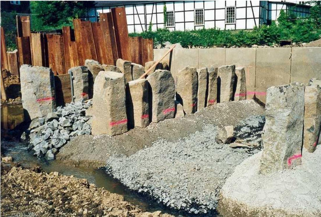
Abb. B.21: Raugerinne mit Beckenstruktur im Bau- Riegel aus großen Wasserbausteinen, raue Sohle mit filterstabilem Aufbau (Betzdorf/Sieg, Rheinland-Pfalz).
