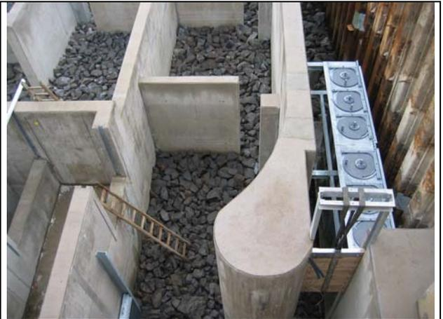
FAA im Bau, rechts Strömungsleitereinrichtung am Einstieg
