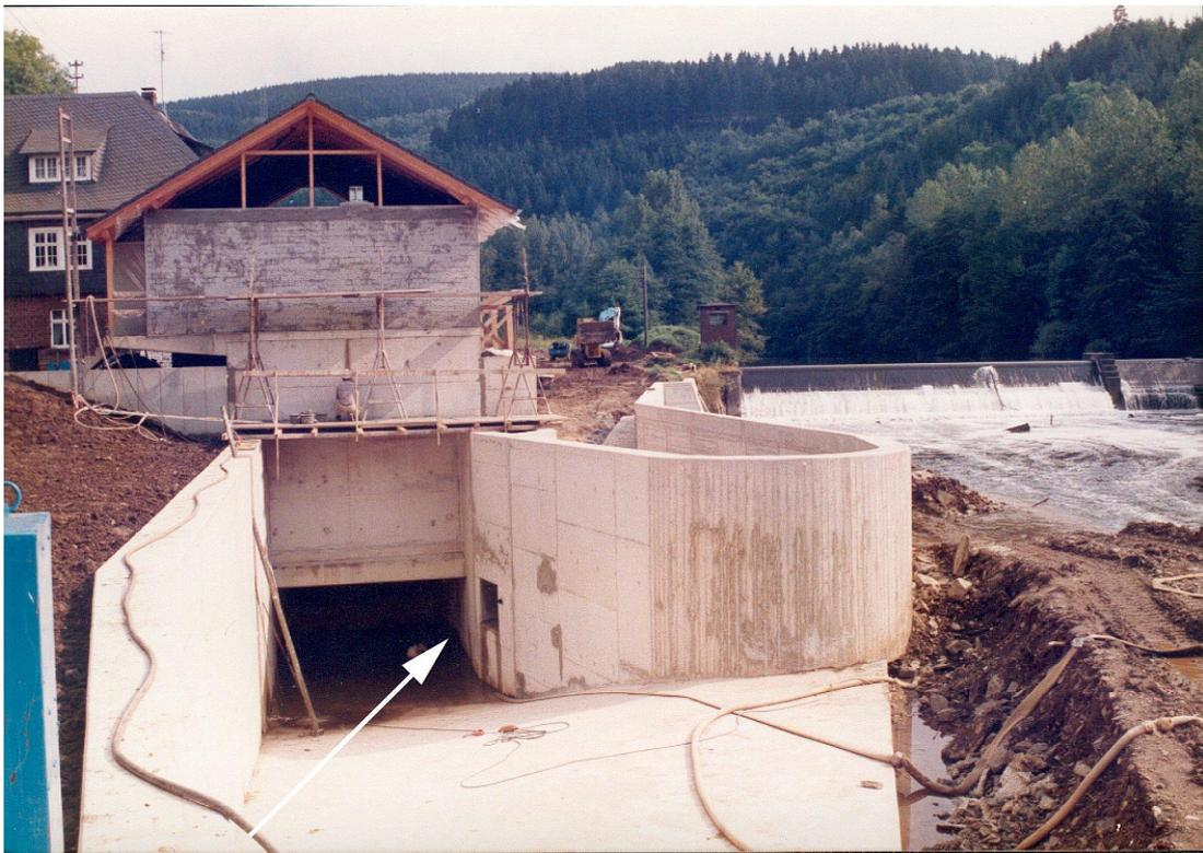
Abb. B.32: Unterwasserseitige Ansicht einer im Bau befindlichen Wasserkraftanlage an der Sieg (Rheinland-Pfalz, 1985). Rechts ist neben dem Saugrohraustritt der Einstieg in die Fischschleuse erkennbar. Die Schleuse ist parallel zum Krafthaus angeordnet und mündet in den Oberwasserkanal. Funktionskontrollen zu dieser Anlage liegen bisher nicht vor.
