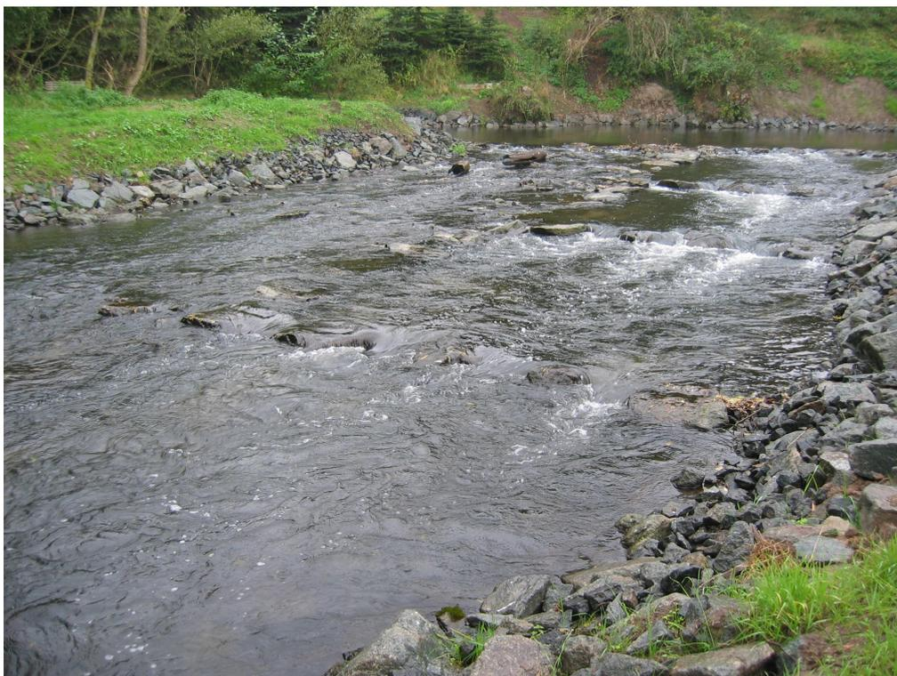
Abb. B.26: Geteiltes Raugerinne mit Beckenstruktur und flächigem Gerinne (Hasel, Thüringen), rechts im Bild ist die Beckenstruktur zu erkennen.
