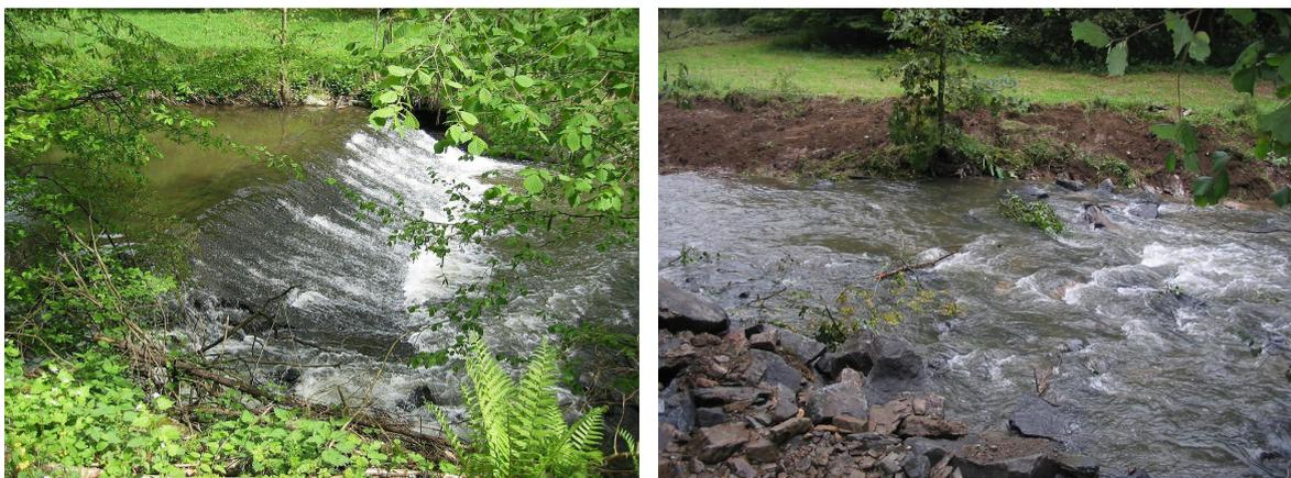
Abb. B.1: Wehr am Saynbach (Rheinland – Pfalz) vor und nach dem Rückbau
