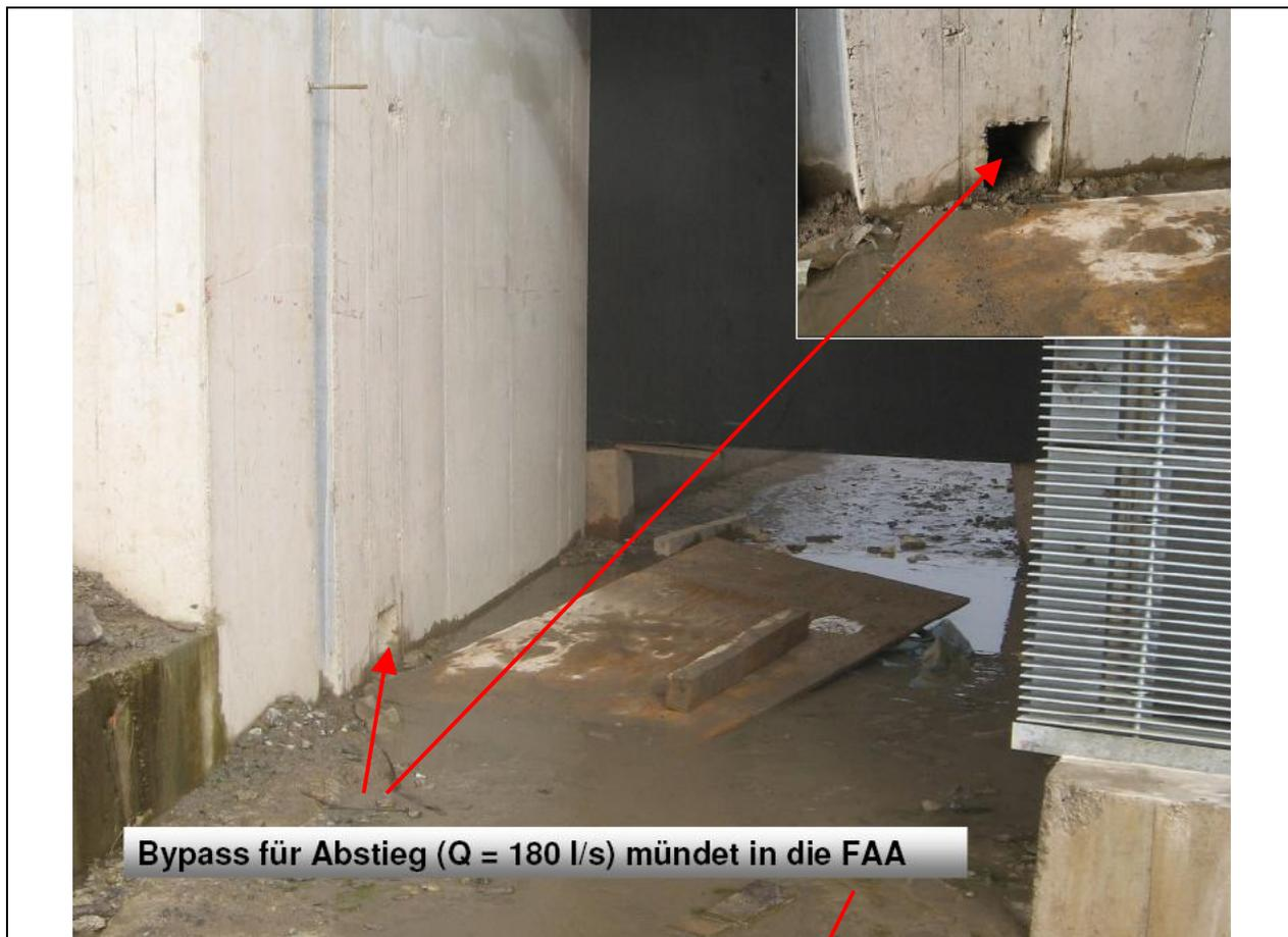
Bypass für Abstieg ( $Q = 180 \text{ l/s}$ ) mündet in die FAA
