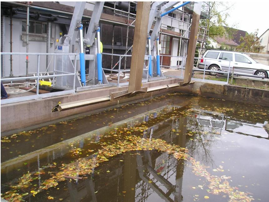
Abb. 7.7: Einlauf Turbine, Vertikalrechen mit lichtem Stababstand von 15 mm (Foto ENBW)
