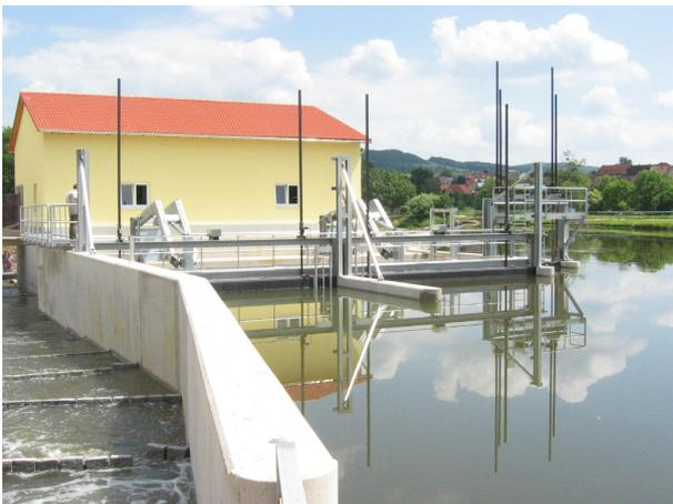
Abb. 7.8: Fischaufstiegsanlage (links im Bild) und Einlauf WKA, Vertikalrechen mit lichtem Stababstand von 15 mm
