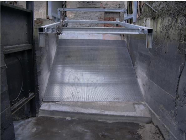
Abb. 7.1: Feinrechenanlage bei der Montage, lichter Stababstand: 5,3 mm
