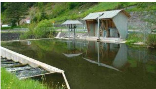
Abb. 7.4: Standort Wehr, Einlauf zum Kanal (WKA) und Auslauf Bypass am rechten Ufer, FAA am linken Ufer (Foto: BLASEL, 2010)
