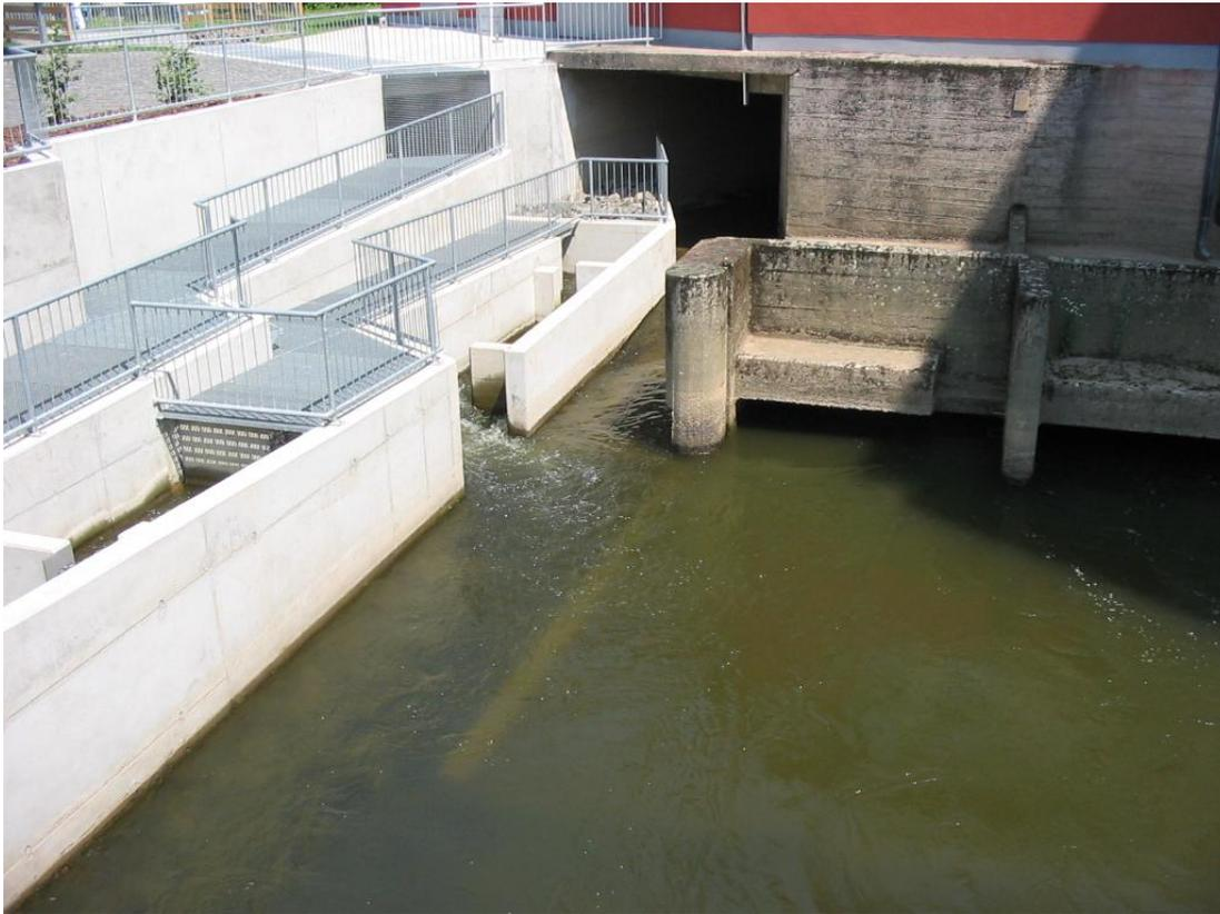
Abb. B.9: Unterwasseransicht der Wasserkraftanlage Klinkelsche Mühle in Gießen (Hessen) mit korrekter Anordnung des Einstiegs in die Fischaufstiegsanlage
