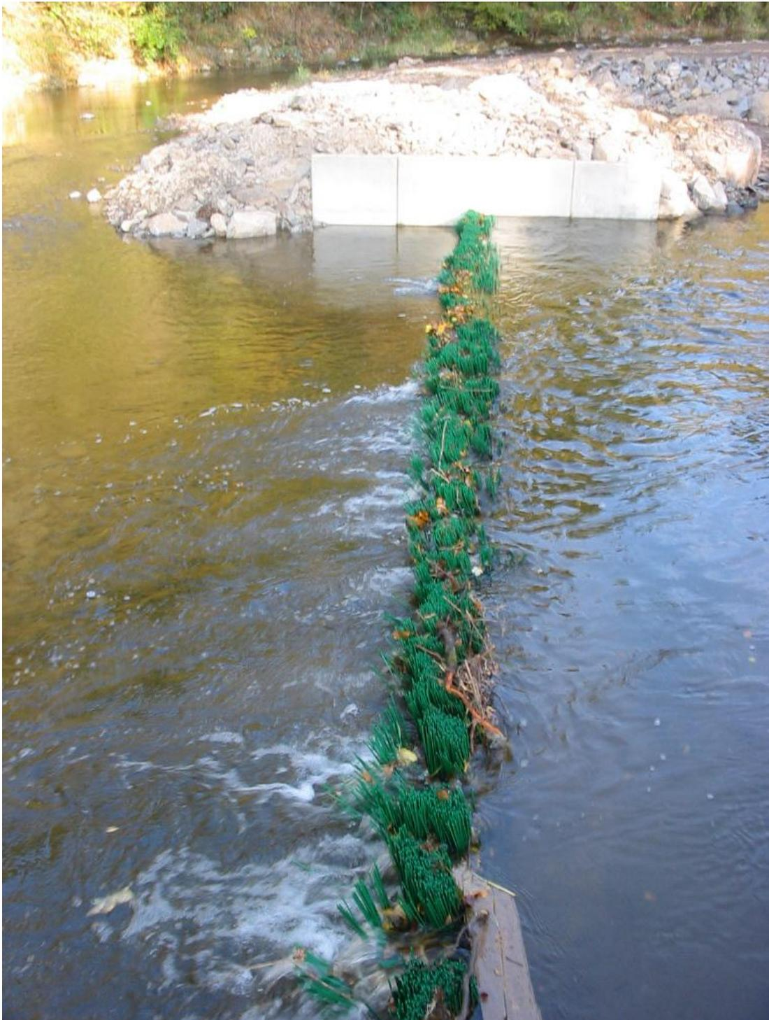
Abb. B.7: Aufwandersperre mit Borsten an der Mündung eines Unterwasserkanals (Our)
