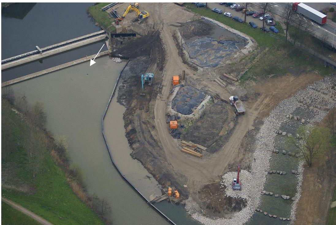
Abb. B.15: Fischaufstiegsanlage Hambeek in Roermond/NL während des Baus. Der Einstieg wurde gezielt neben dem Wehr angeordnet.
