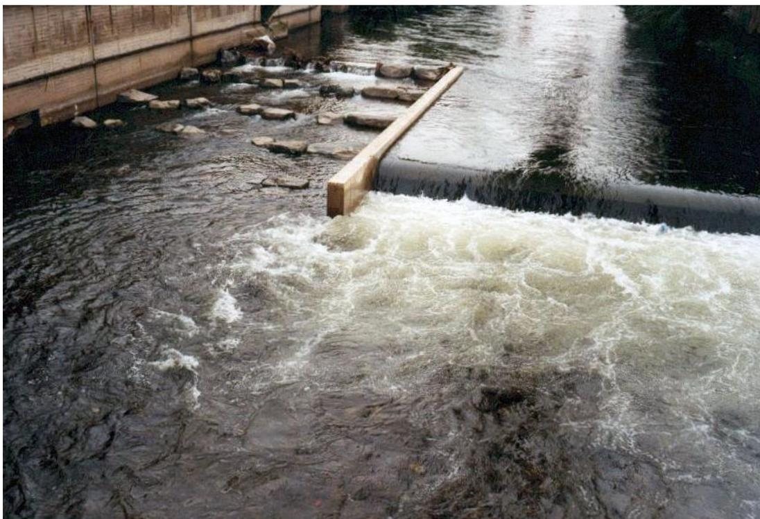
Abb. B.14: Fischaufstiegsanlage Wuppertal-Barmen mit Einstieg unmittelbar neben dem Tosbereich der Wehrklappe.
