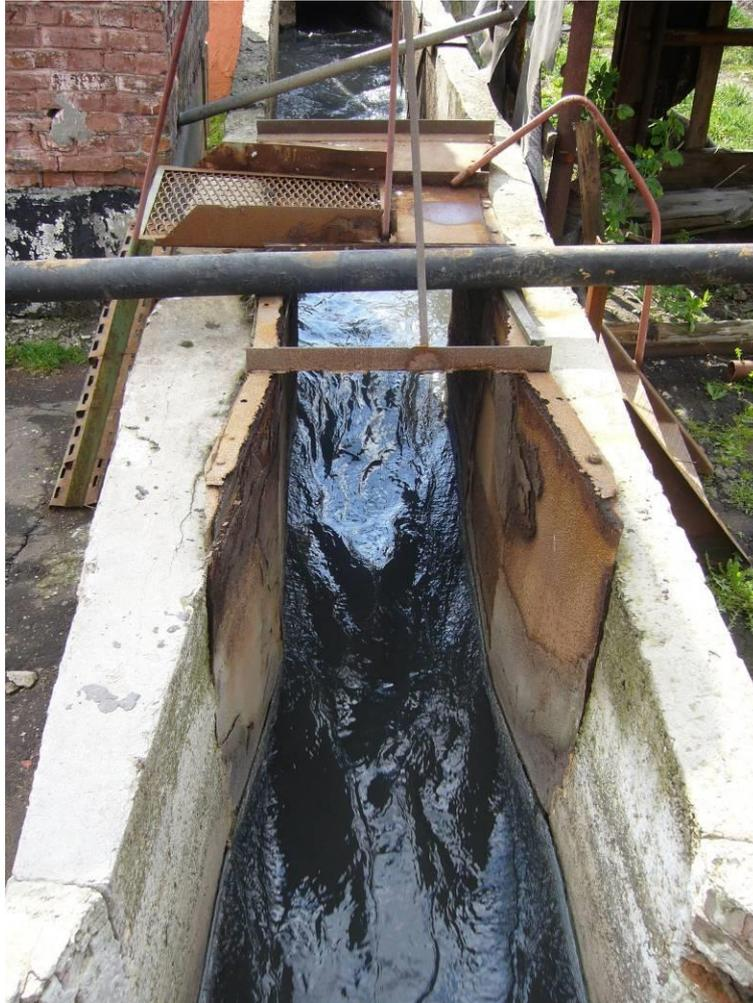
Abbildung 14: Venturi-Messgerinne im Zulauf der KA Červonohrad
