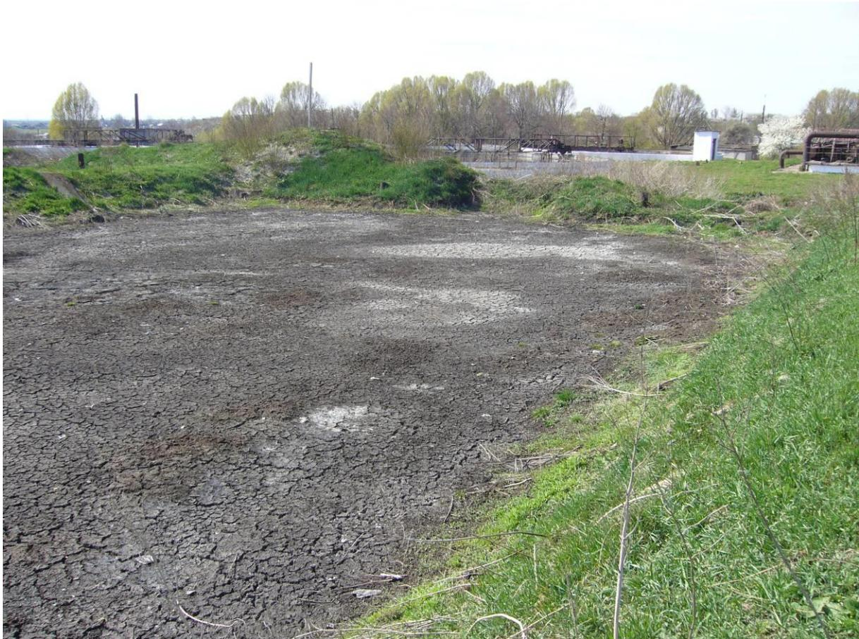
**Abbildung 13: Schlammtrockenplätze auf der KA Novovolyns'k**
