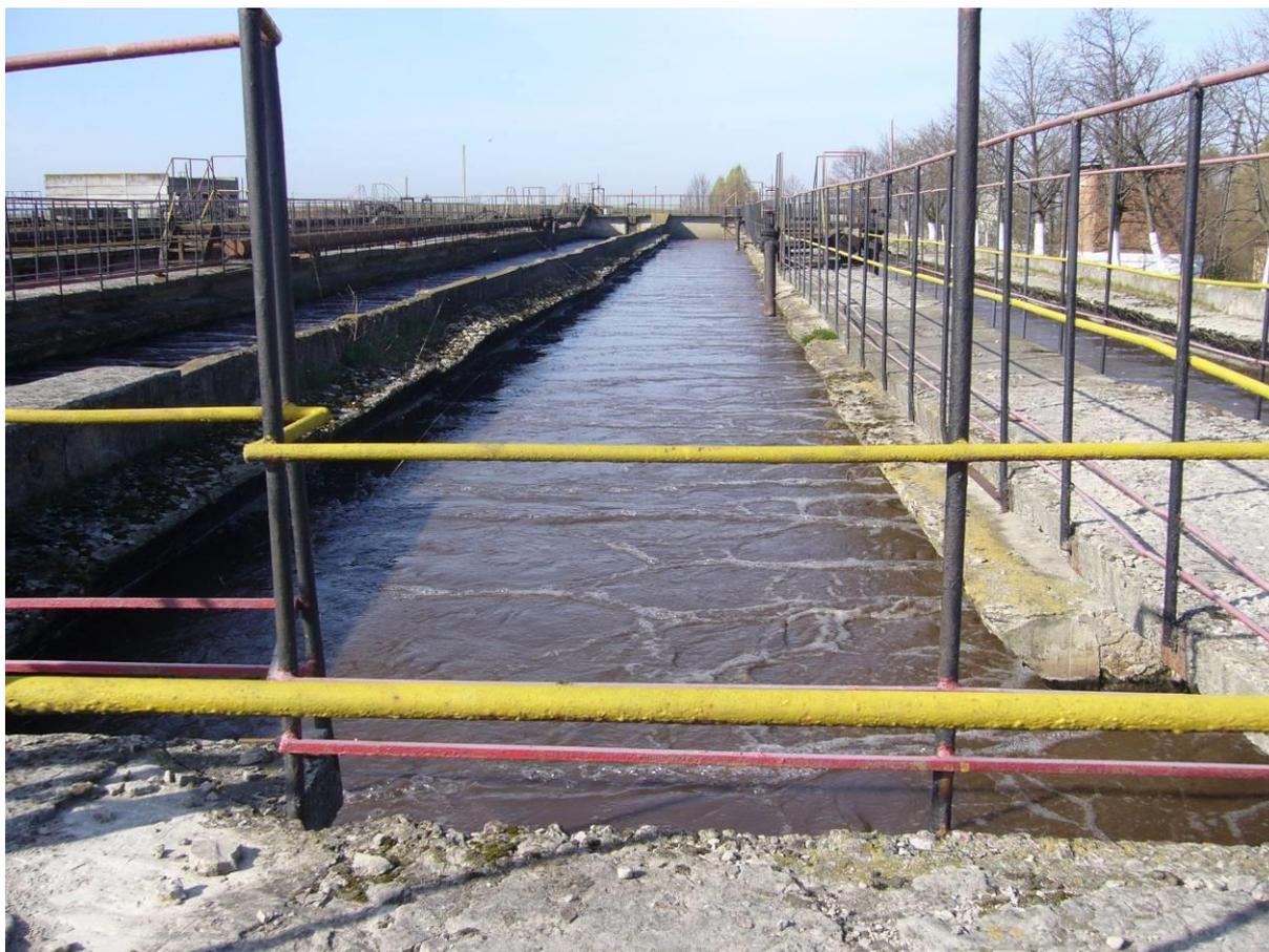
Abbildung 12: Belebungsbecken auf der KA Novovolyns'k
