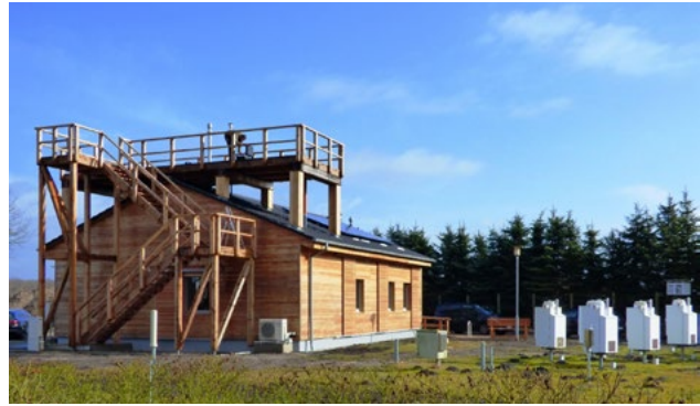
Das neue Gebäude der Luftmessstation in Zingst
