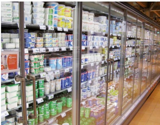
Kühlmöbel einer transkritisch arbeitenden CO<sub>2</sub>-Kälteanlage
