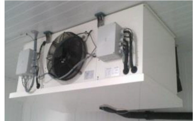
Direkte Montage im Tiefkühlraum
