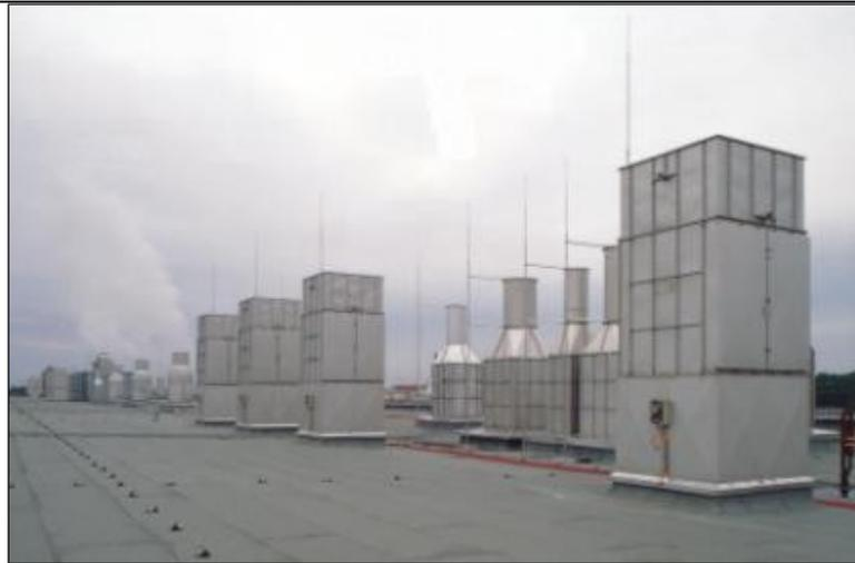
**Abbildung 7.37: Schalldämpfer auf dem Dach einer Papierfabrik**
