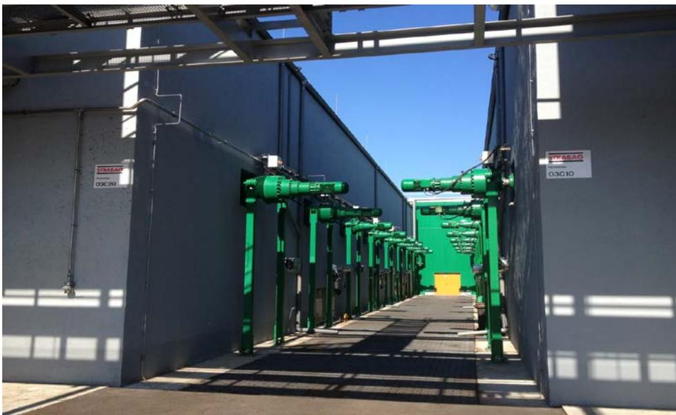
Горизонтальный бетонный ферментатор с приводами для лопастной мешалки
