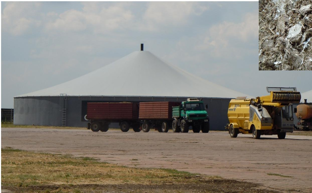
Gärbehälter mit gasdichter Haube aus Folie / бродильный чан с газопроница-емой
