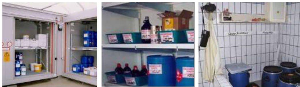
Рис. 9: Примеры организации мест хранения химических отходов
