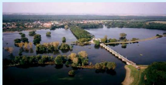
Pretziner Wehr zur Regulierung der Elbe im Hochwasserfall, Bereich Magdeburg (LHW Sachsen-Anhalt)
