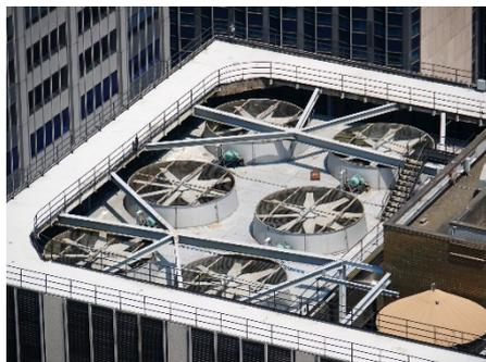
Verdunstungskühlanlagen sind Anlagen, bei denen Wasser gekühlt wird, indem durch Verdunstung Wärme an die Umgebungsluft abgeführt wird. Sie umfassen unter anderem eine Verrieselungs- oder Verregnungseinrichtung für Kühlwasser und einen Wärmeüberträger (VDI 2047 Blatt 2).
