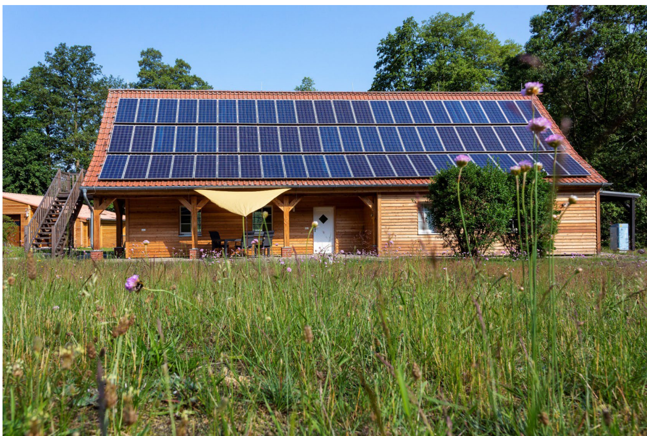
Das Stationsgebäude der UBA-Messstation Neuglobsow am Stechliner See in Brandenburg.
