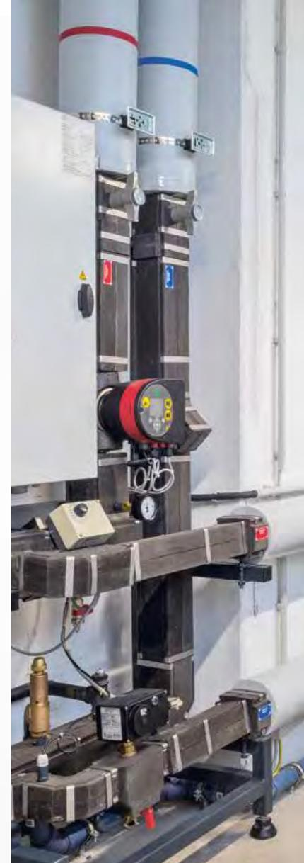
▲ Die Fernwärmeübergabestation versorgt die Wohnungsstationen mit Wärme zur Warmwassererzeugung.
