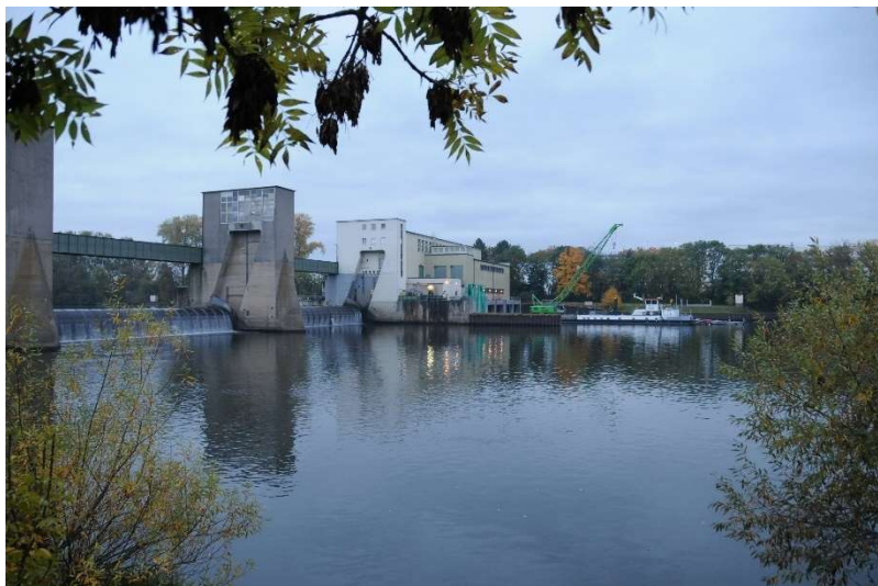
Monitoring Wasserkraft- anlage Eddersheim
