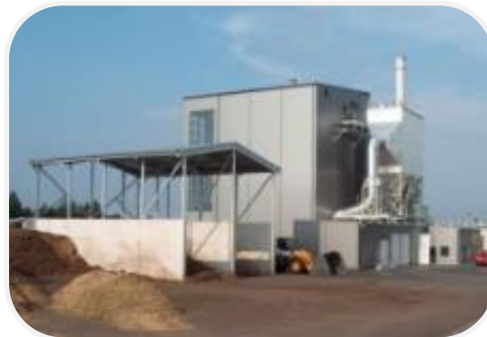
Heizkraftwerke (für Holz, auch für Stroh)
