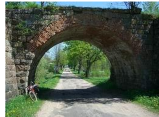
Железнодорожный мост в пос. Калинино Eisenbahnbrücke in der Siedlung Kalinino
