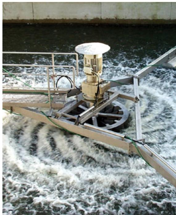
Anhang 5, Abb. 14: Crown Oberflächenbelüfter der SBR-Anlage (System BIOGEST)
