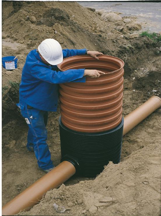
Anhang 5, Abb. 1: Inspektionsschacht Freispiegelleitung (System Wavin)
