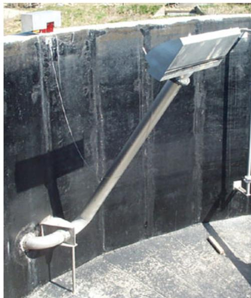
Anhang 5, Abb. 16: Abflussregler SBR Anlage (System BIOGEST)
