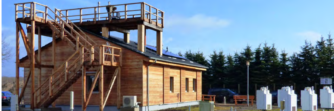
An der UBA-Messstation in Zingst an der Ostseeküste wurde im Juni 2015 ein neues Stationsgebäude in Betrieb genommen. Es entspricht den Passivhausstandards.
