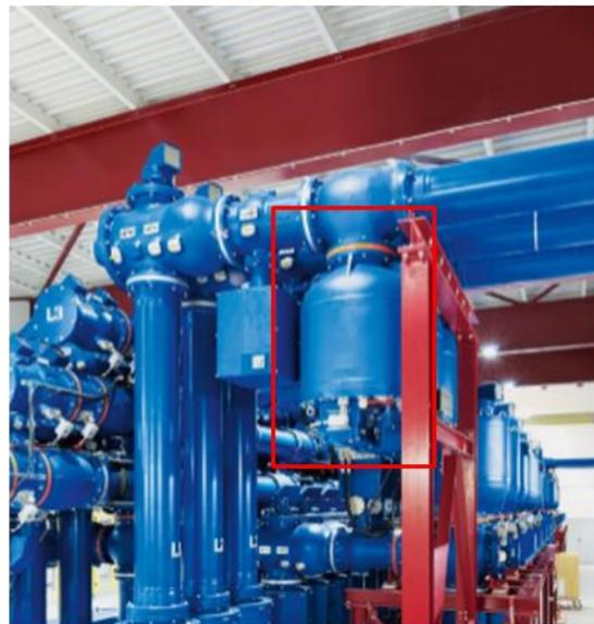
Abbildung 17: Hochspannungsmesswandler
