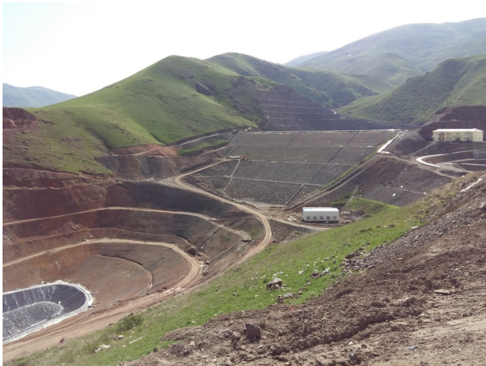
Basisflutung des Rückhaltebeckens der Mine Alтынкен (Quelle: Staatskomitee für Industrie, Energie und Bergbau Kirgistans)
