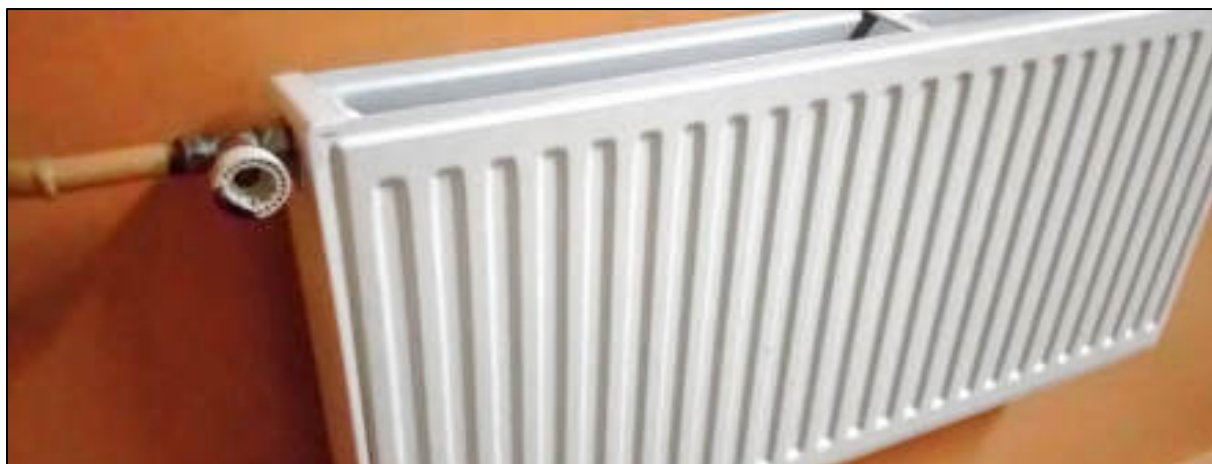
Rys. 125: Centralnie sterowany grzejnik bez własnego termostatu w jednej z oglądanych nieruchomości
