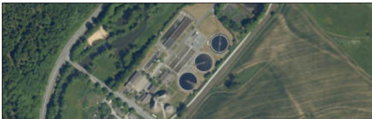
Rys. 181: Widok z lotu ptaka na oczyszczalnię ścieków w Selbitztal
