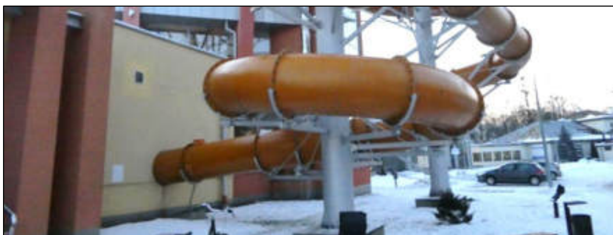
Rys. 108: Niezaizolowana zjeżdżalnia w Parku Wodnym w Hajnowce
