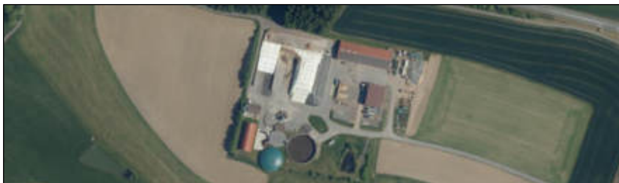
Rys. 187: Widok z lotu ptaka na biogazownię rolniczą w Meierhof
