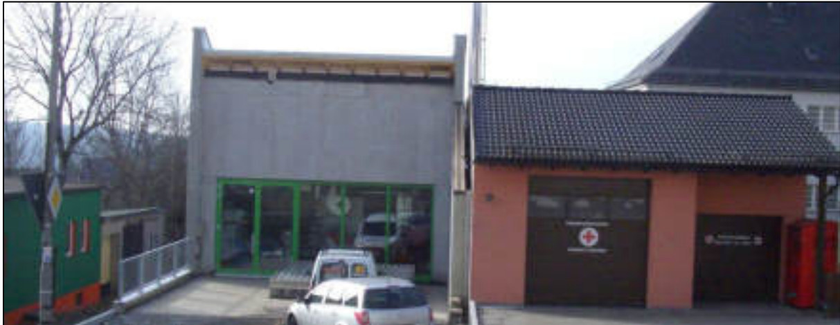
Rys. 186: Oszklona elektrociepłownia w Nordhalben po zakończeniu budowy
