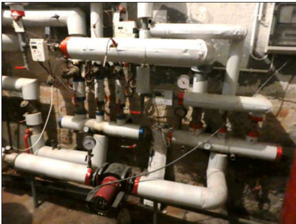
Rys. 110: Dystrybucja ciepła w Starostwie Powiatowym w Hajnówce z brakującym zaworem mieszającym i trzema pompami sterowanymi.
