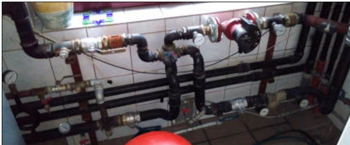
Rys. 122: Niezaizolowane rury grzewcze w kotłowni badanej nieruchomości
