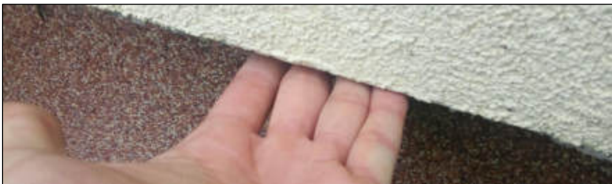
Rys. 119: Widok z bliska ok. 5 cm grubości warstwy izolacyjnej na elewacji
