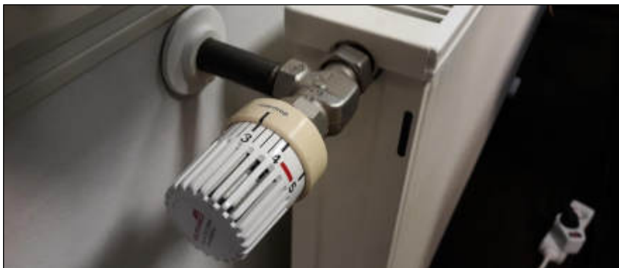
Rys. 126: Przykład regulowanego zaworu termostatycznego grzejnika
