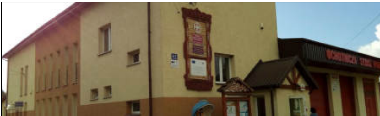
Rys. 118: Zaizolowane przegrody zewnętrzne budynku komunalnego
