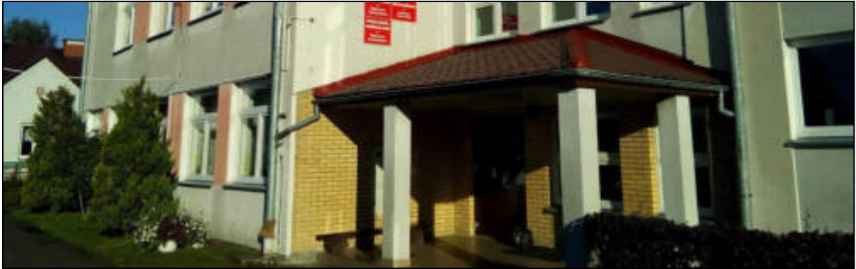
Abb. 128: Ungedämmter Eingangsbereich der Schule von Dubicze Cerkiewne mit metallener Tür
