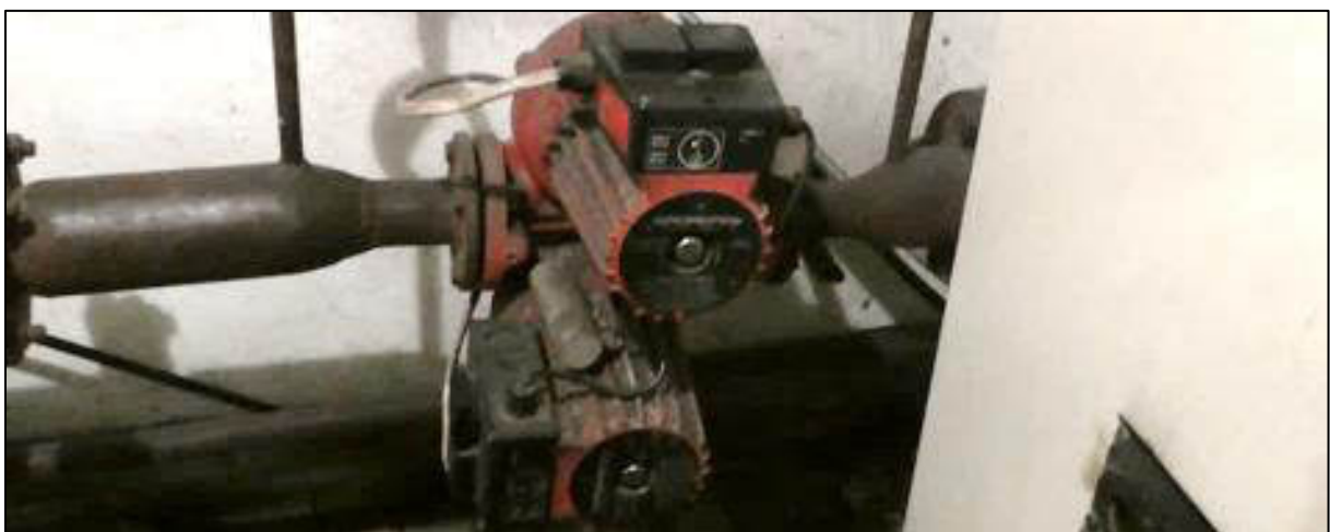
Abb. 112: Ungeregelte Doppelpumpe in der Verteilung im Kulturhaus Hajnówka
