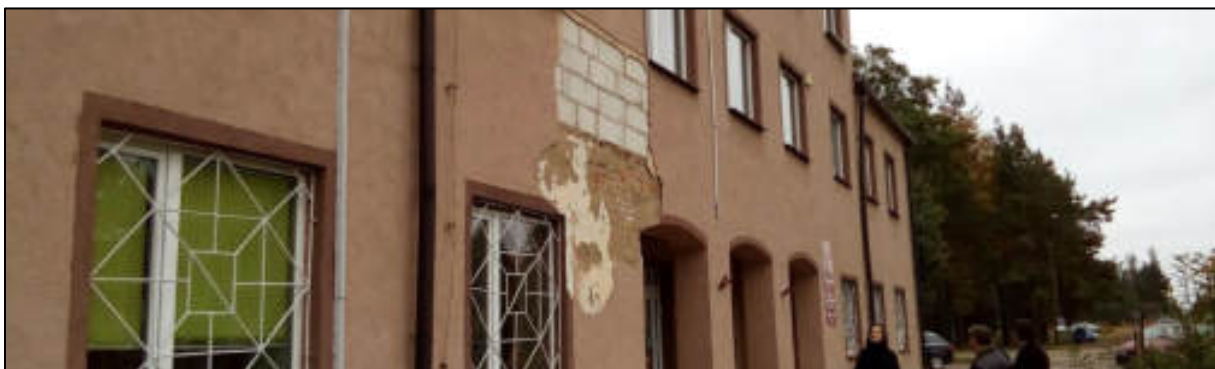
Abb. 117: Ungedämmte Gebäudehülle einer kommunalen Liegenschaft
