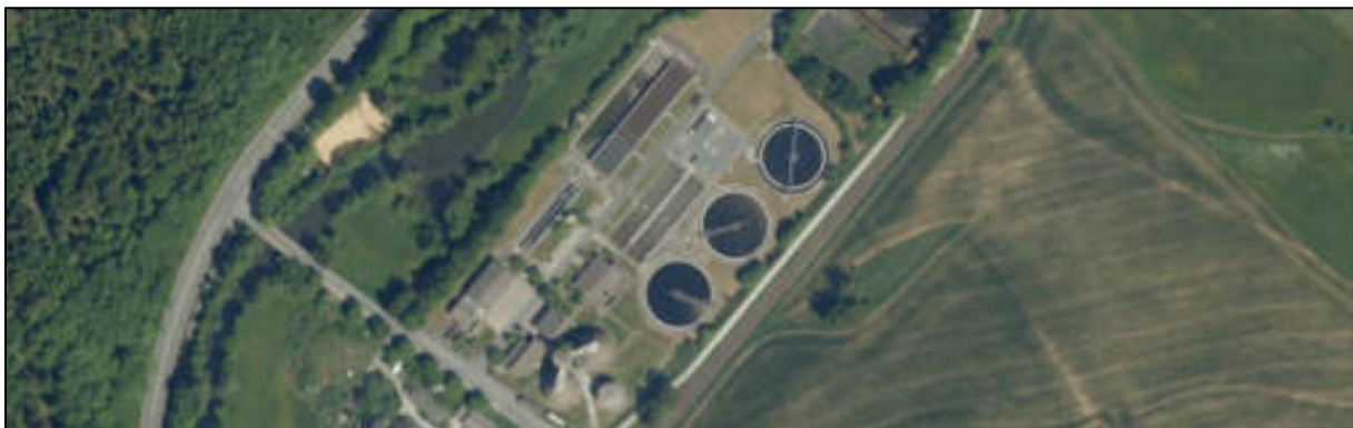
Abb. 181: Die Kläranlage des Abwasserverbands Selbitztal im Luftbild
