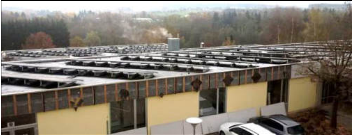
Abb. 179: Blick auf die besichtigte Photovoltaikanlage auf der Schule in Schwarzenbach a.d. Saale
