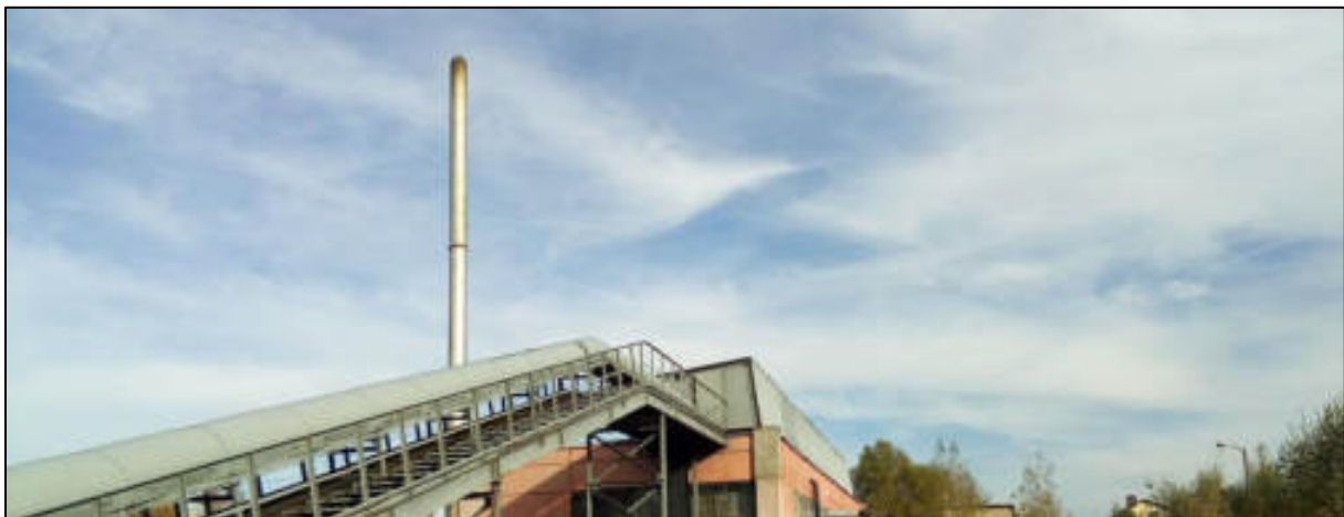
Abb. 132: Schornstein der Heizzentrale des Fernwärmebetriebs der Stadt Hajnówka
