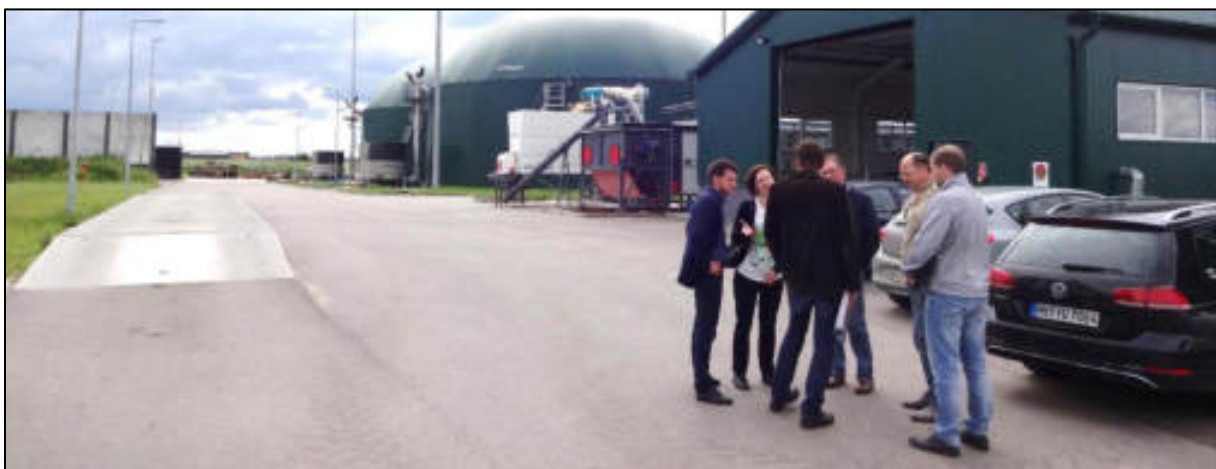
Abb. 169: Erörterungen zur zukünftigen Abwärmennutzung mit dem Betreiber der Biogasanlage in Stary Kornin (QUELLE: EVF 2017, FOTOGRAF: RALF DEUERLING)
