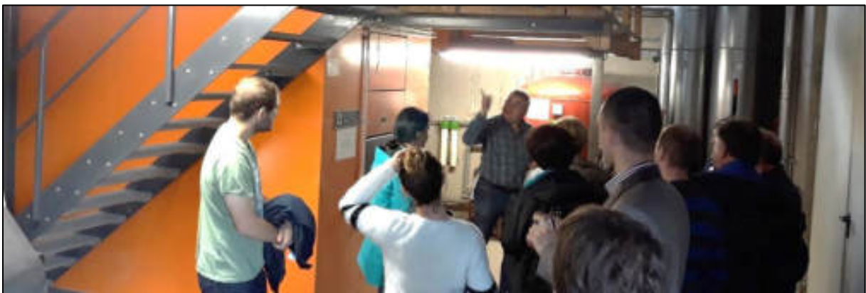
Abb. 191: Die Teilnehmer des praxisorientierten Workshops am Heizwerk der kommunalen Liegenschaften des Landkreises Forchheim in Ebermannstadt
