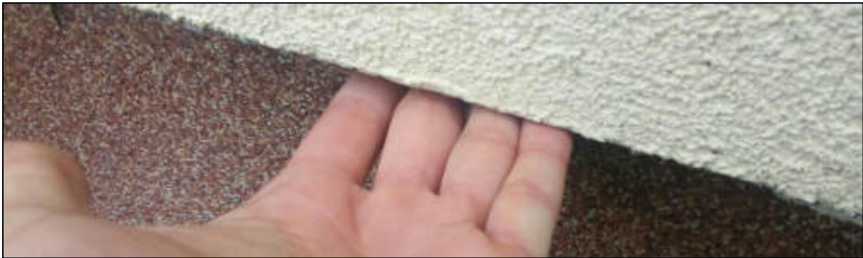
Abb. 119: Nahaufnahme einer ca. 5 cm dicken Dämmschicht an der Fassade
