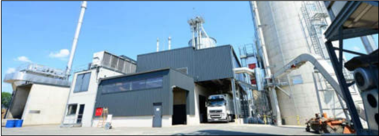
Abb. 204: Die Anlagen der WUN Bioenergie in Holenbrunn
