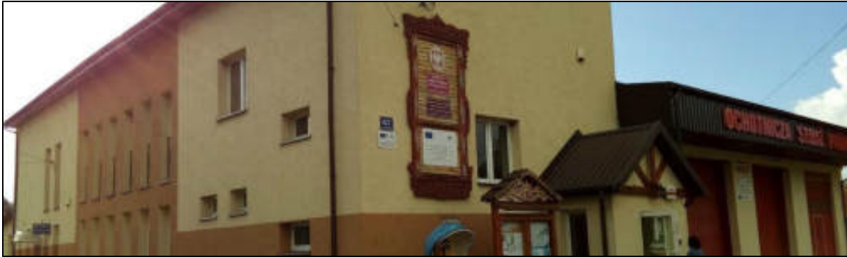
Abb. 118: Gedämmte Gebäudehülle einer kommunalen Liegenschaft
