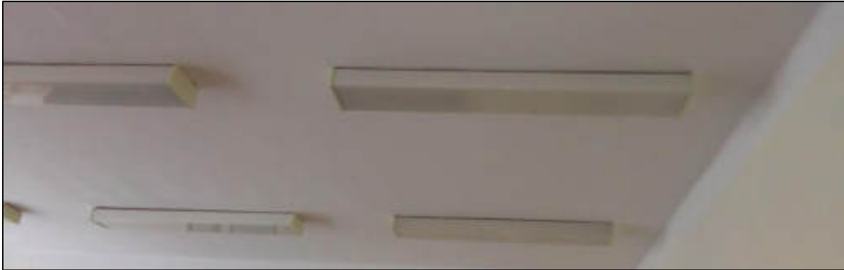
Abb. 120: Häufig vorgefundene konventionelle Beleuchtung mit größerem Einsparpotenzial
