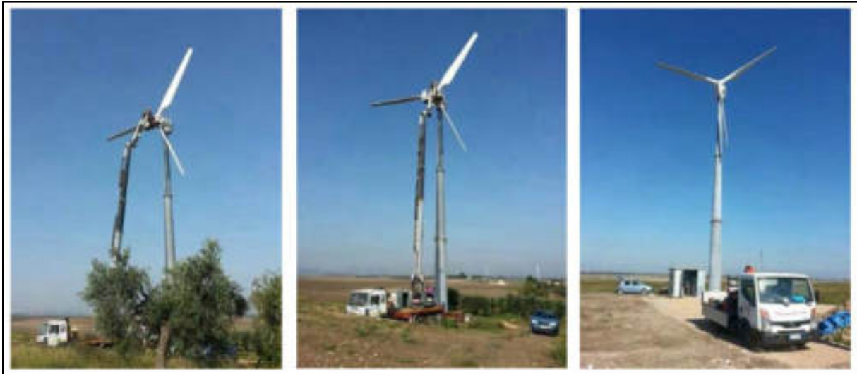
Abb. 88: Aufbau einer Kleinwindkraftanlage in Italien
