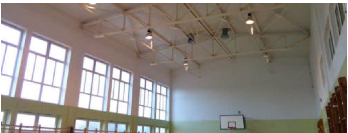
Abb. 129: Ungedämmte Hallendecke einer begangenen Sporthalle
