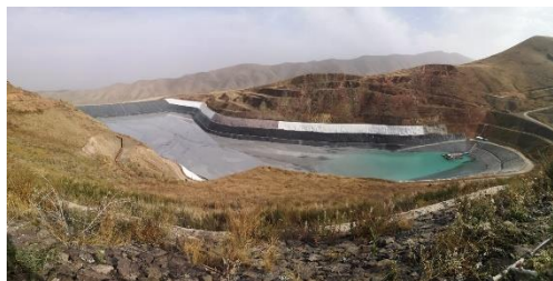
Хвостохранилище рудника Алтынкен
