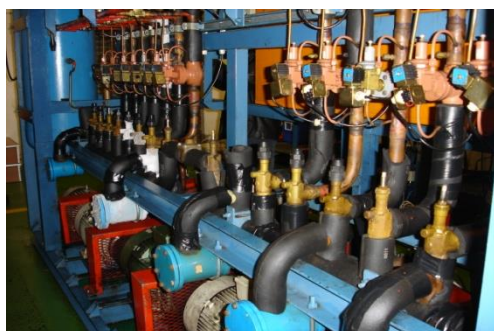
Хладилна инсталация на супермаркет
