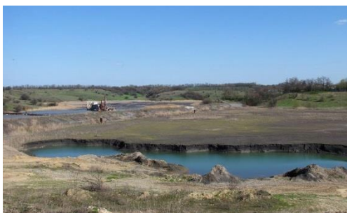
Aschespeicher eines thermischen Kraftwerks in der Ukraine
