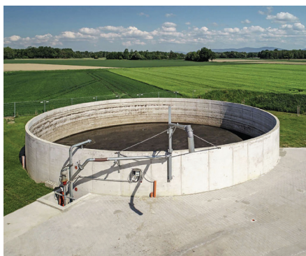
❶ Рис. 5: Резервуар из бетонной смеси
