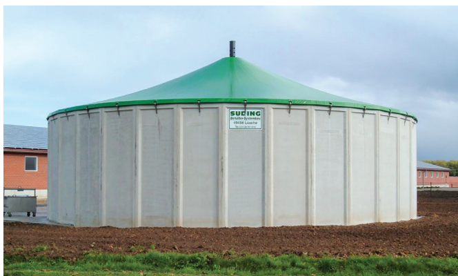
❶ Рис. 6: Блочный резервуар.
