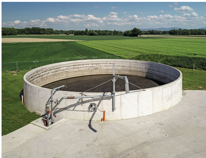
Fig. 5: Rezervor din amestec de beton
