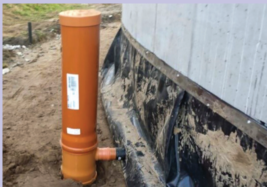
Рис. 9: Дренажная (сливная) труба со смотровой шахтой.
