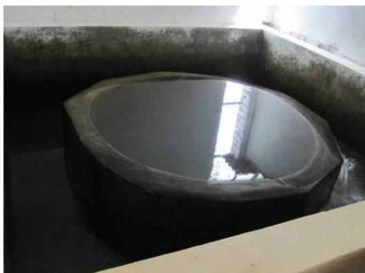
Abbildung 7: Schnellfilter der Wasseraufbereitungsanlage Tomești (Quelle: COPLAN AG)
