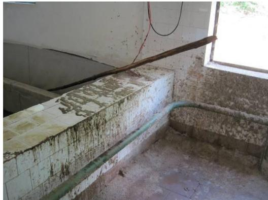
Abbildung 8: Filterbecken der Wasseraufbereitungsanlage Văliug (Quelle: COPLAN AG)
