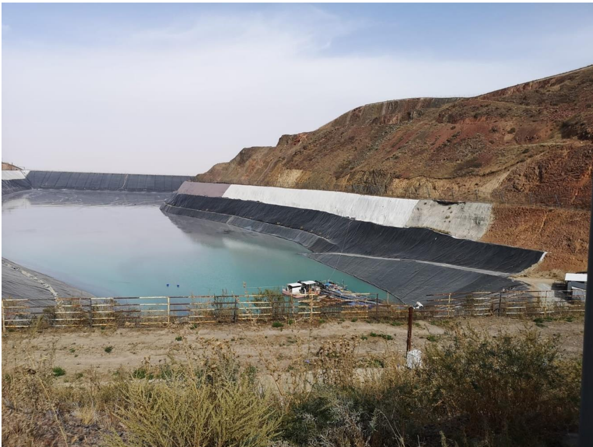
Das industrielle Rückhaltebecken des Alтынкен-Abbaubetriebes der T. L. Lagerstätte, Kirgistan (Source: Oleksandra Riedl)
