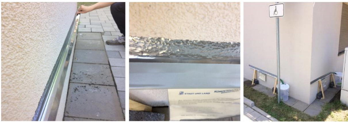
Abbildung 7: Installation der Fassadenrinnen im Testgebiet A
