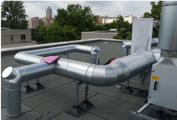
Abbildung 55: Dachaufbauten aus verzinkten Rohren in Testgebiet A
