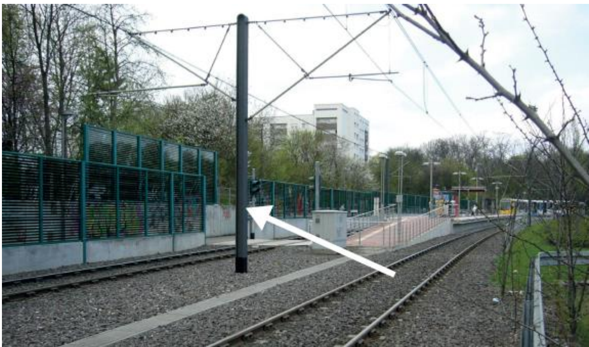
Abbildung 64: Beispiel für eine Schallschutzwand aus Glas auf Betonsockel
