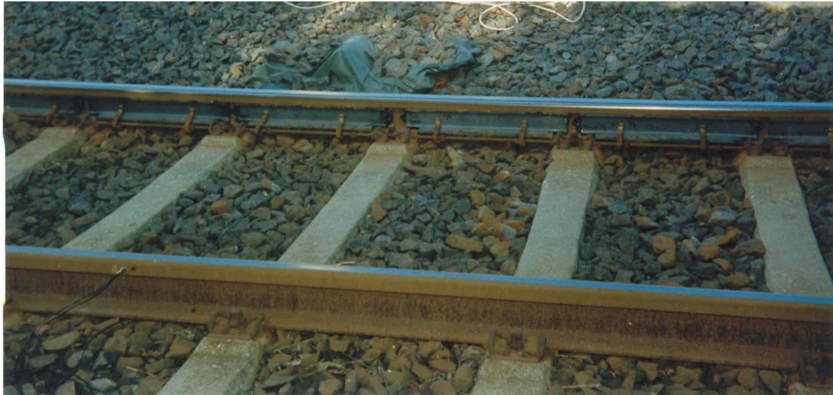
Abbildung 48: Beispiel für Schienenstegdämpfung, Befestigung mit Klammern
