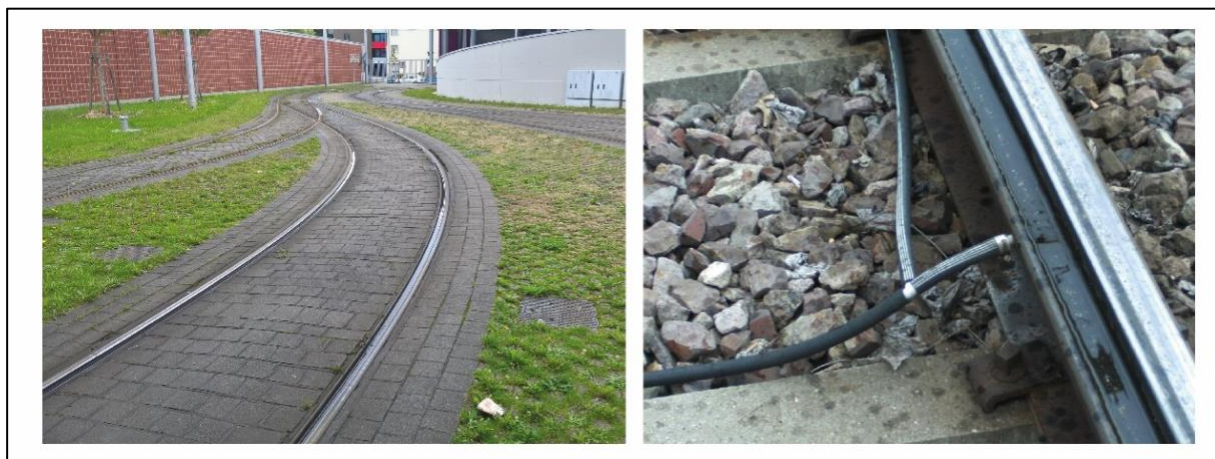
Abbildung 58: Bewässerung der Rillenschienen – Beispiel Karlsruhe
