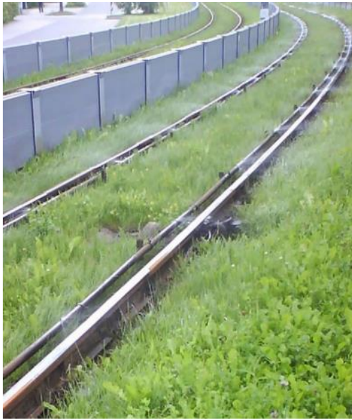
Abbildung 57: Schienenberegung zur Vermeidung von Kurvengeräuschen – Beispiel Straßenbahn Stuttgart
