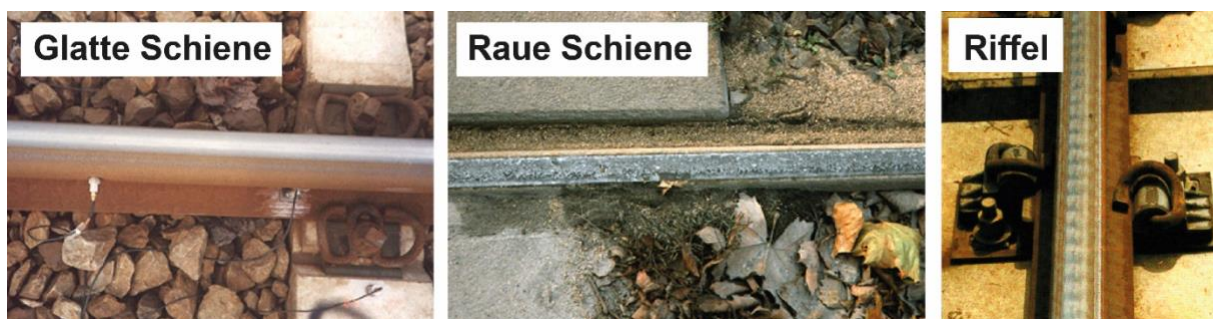
Abbildung 15: Beispiele für Schienenrauheiten
