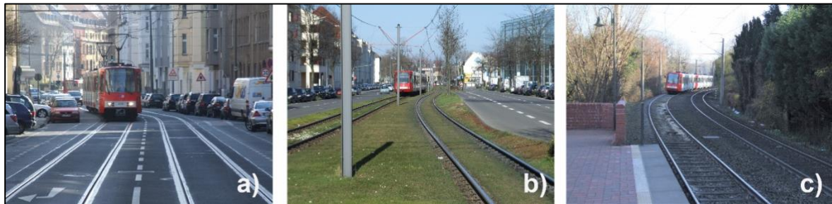
Abbildung 1: Bahnkörper der Straßenbahn
