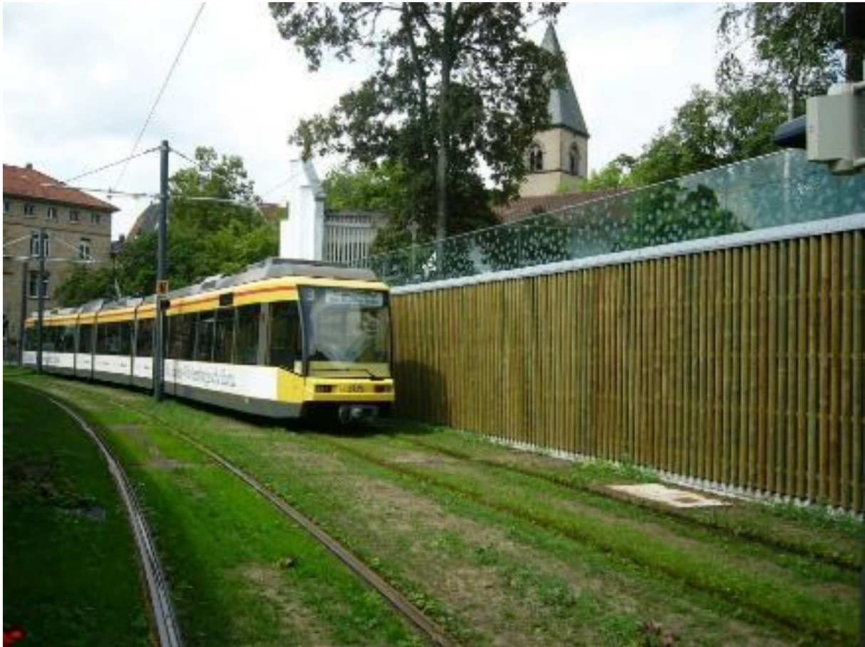
Abbildung 65: Einsatz einer hohen Holz-Glas-Schallschutzwand – Beispiel Karlsruhe
