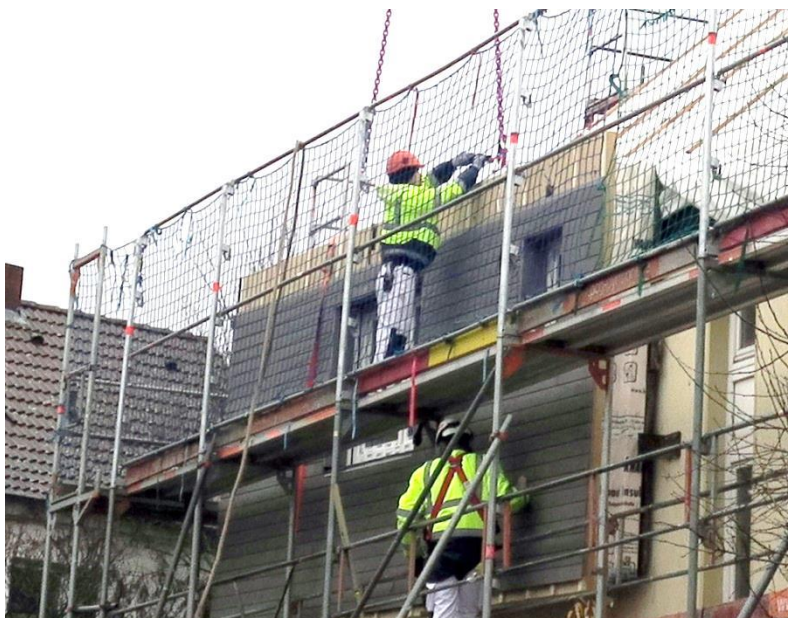
Abbildung 19: Montage eines vorgefertigten Fassadenelements im Pilotprojekt Hameln
