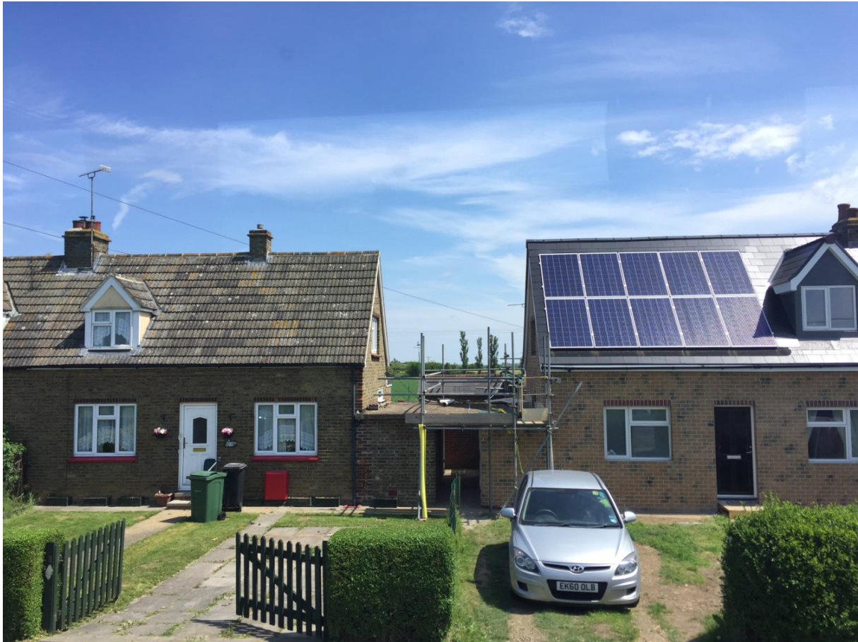
Abbildung 11: Sanierte Doppelaushälften in Maldon, Essex
