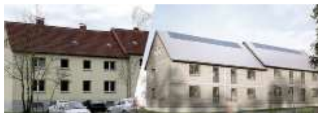
3 Bei dem Projekt „Kuckuck“ der arsago ACM GmbH in Hameln werden drei zweigeschossige Mehrfamilienhäuser mittels vorgefertigter Fassaden- und Dachelemente in kürzester Bauzeit auf den KfW-55 Effizienzstandard gebracht.
