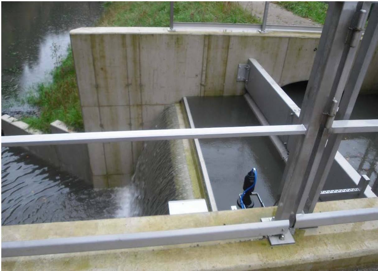
Abbildung 5: Beispiel einer Mischwasserentlastung
