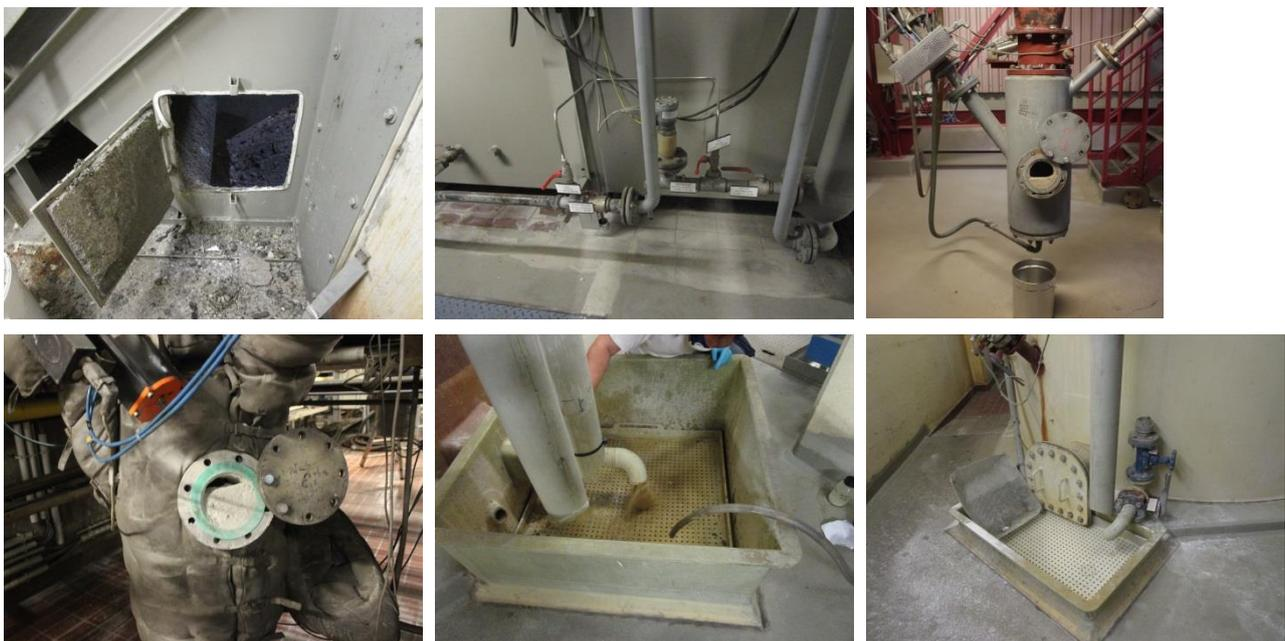
Rostschlacke (links oben); Entschlackerwasser (Mitte oben); Zyklonstaub (links oben); Gewebefilterasche (links unten); Waschwasser Stufe 1 (Mitte unten); Waschwasser Stufe 2 (rechts unten)
