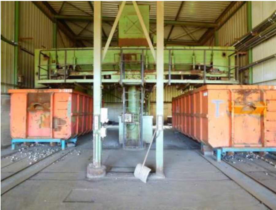
Abbildung 151: Probennahmestelle Probe 4 (Schredderanlage 1) Schredderleichtfraktion < 180 mm
