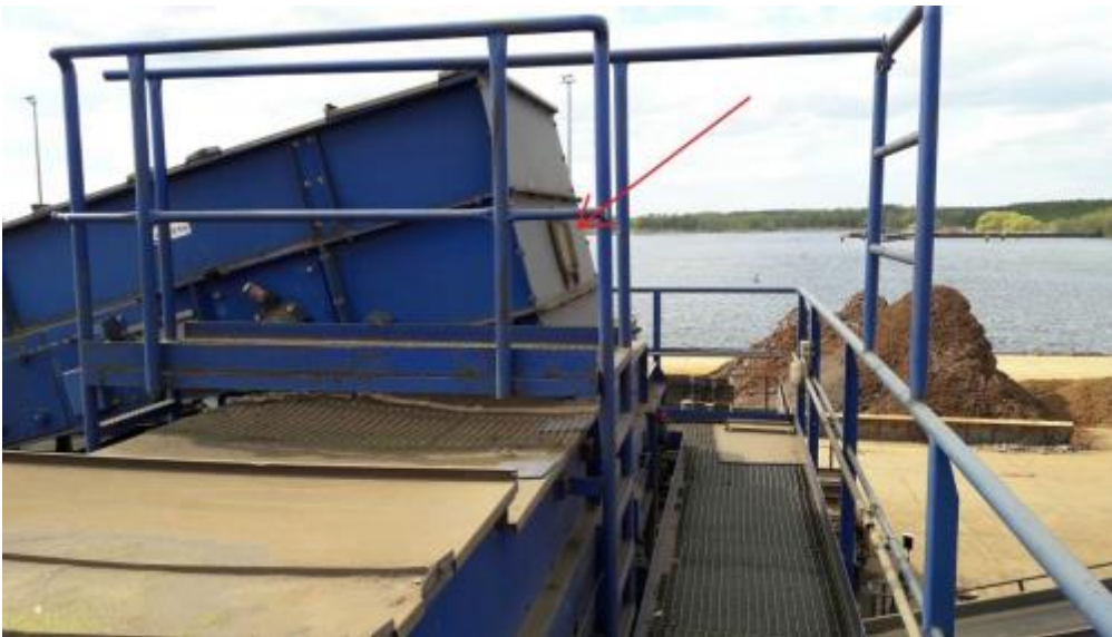
Abbildung 159: Probennahmestelle Probe 4 (Schredderanlage 2) Schredderleichtfraktion < 180 m
