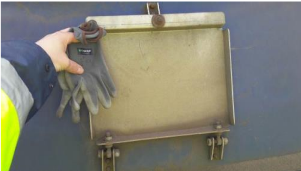
Abbildung 158: Beprobungsklappe (Wartungsluke Band SLF Band 2) für Fallstrom der Probennahmestelle Probe 4 (Schredderanlage 2) Schredderleichtfraktion < 180 mm
