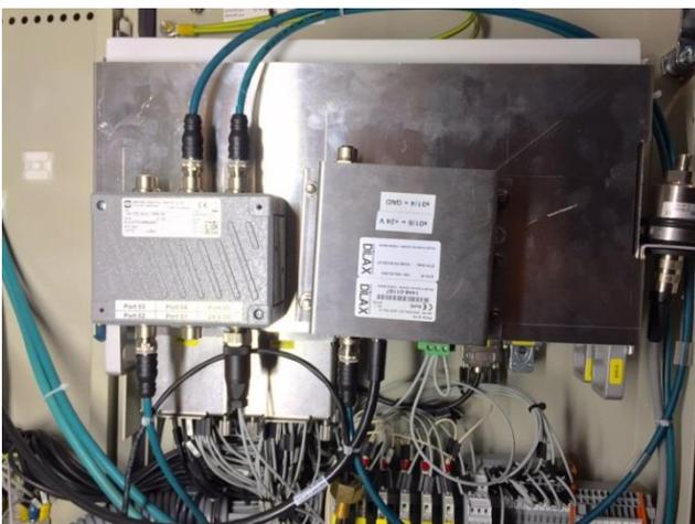
Eingebautes und angeschlossenes oberes Schaltschrankmodul im Wagen TW7. Quelle: eigene Darstellung, Liebherr
