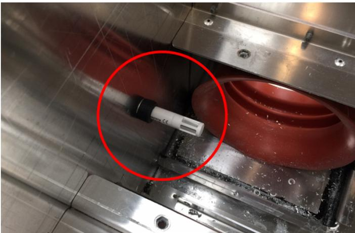
Position des Temperatur- und Feuchtesensors im Kompaktklimagerät. Quelle: eigene Darstellung, Liebherr
