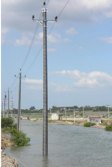
Abbildung 28: Stabile Strommasten aus Verbundstoffen von BASF
