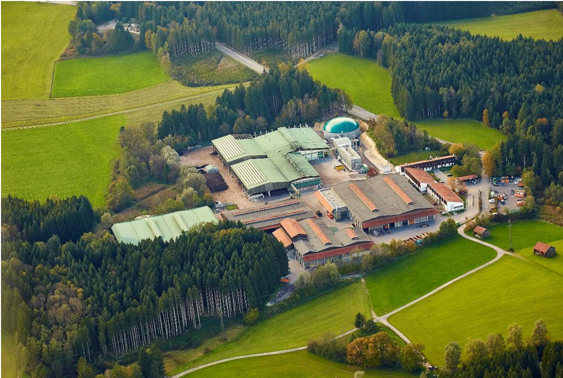
Abbildung 69: Luftbild Bioabfallbehandlungsanlage Quarzbichl
