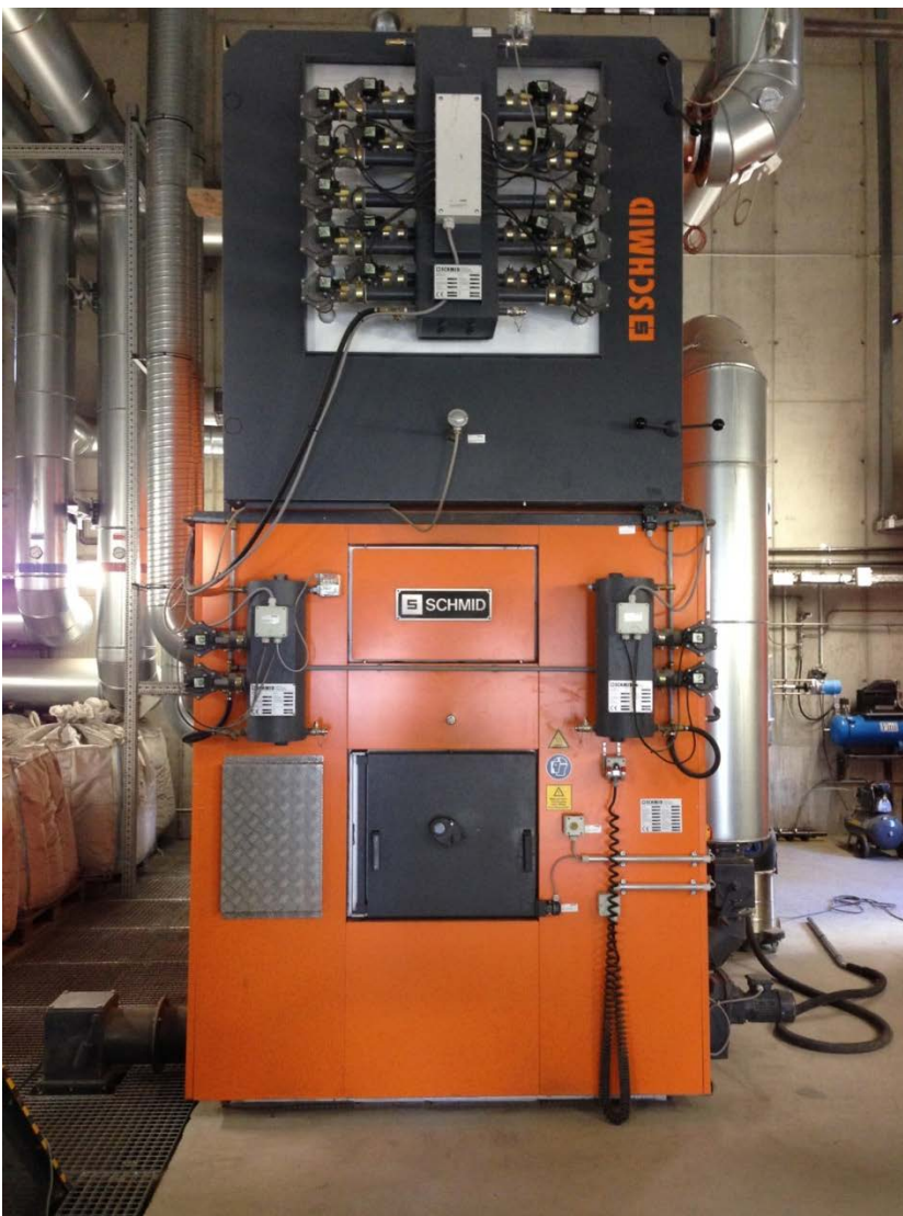
Abbildung 76: Heizkessel Kreiskrankenhaus Heppenheim | © ZAKB Lampertheim
