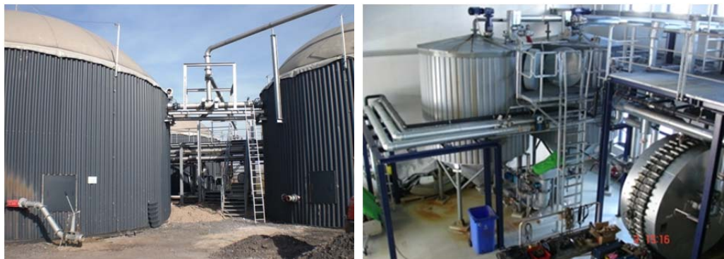
Figure 16: Vue sur les composants principaux des installations de fermentation anaérobies par voie humide en Allemagne (à gauche : Cuve de fermentation, à droite : Ligne de traitement préliminaire, sources : Tim Hermann; Intecus)
