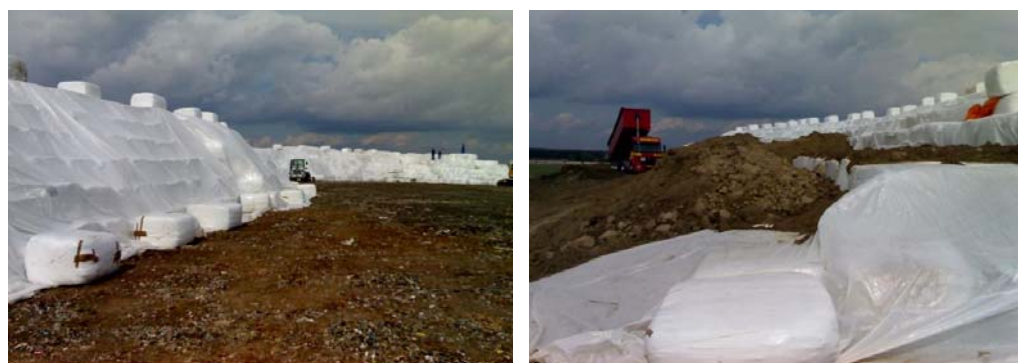
Figure 1: À gauche : Film de recouvrement /à droite : Couche de terre supplémentaire (Sources : INTECUS GmbH)
