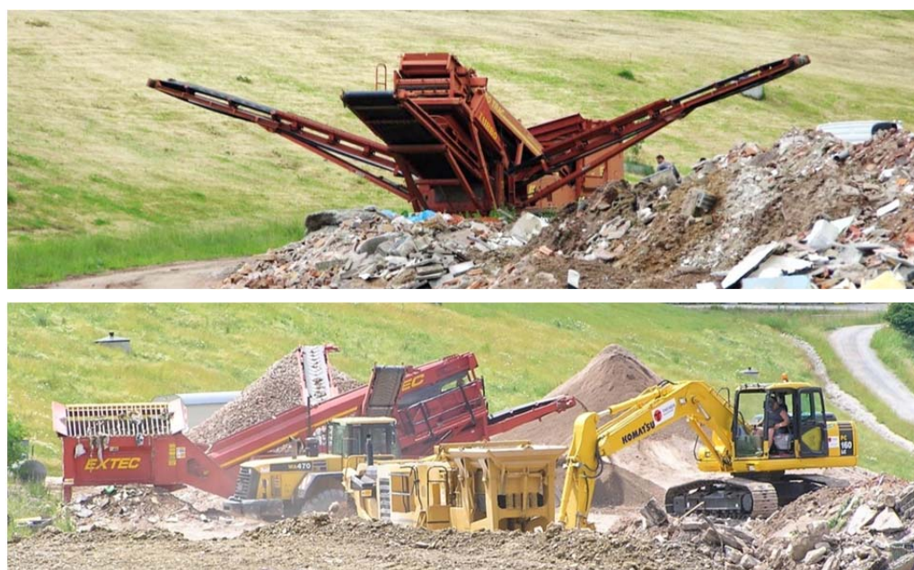
Figure 1: Installations de traitement mobiles pour gravats (Sources en haut & en bas : Jochen Zellner, Landkreis Neustadt/Aisch-Bad Windsheim, www.abfallbild.de )
