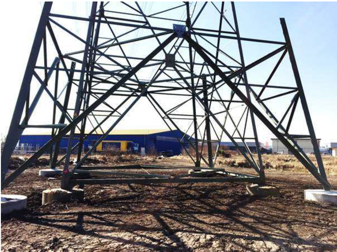
Abbildung 12: Standortgleicher Ersatz eines Mastes
