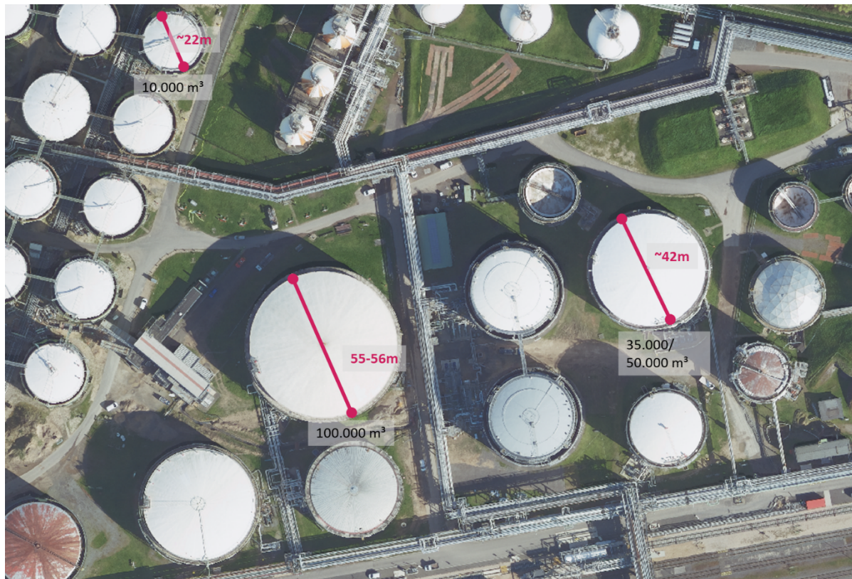
Abbildung 3: Messung der Lagertankgrößen
