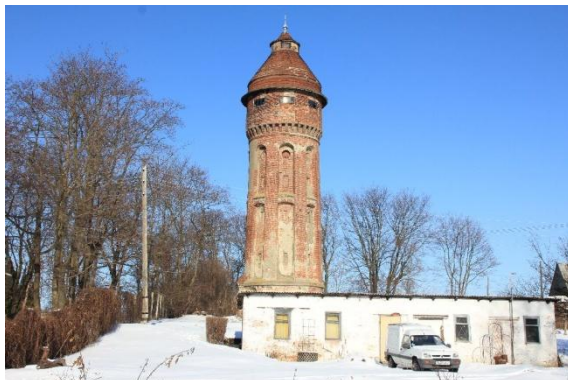
Ansicht des Wasserturms auf dem Gelände des Wasserwerkes in Primorsk
