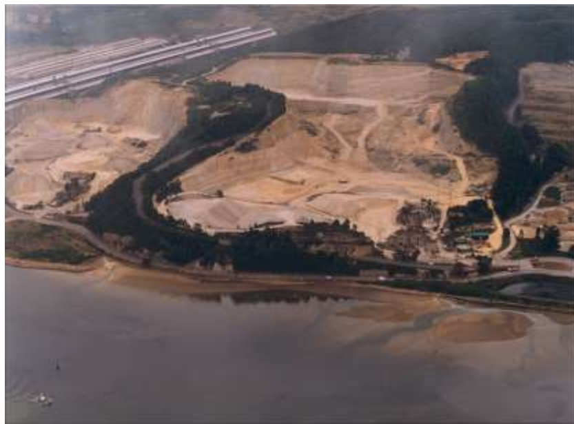
August 1999: vor Verfüllung
