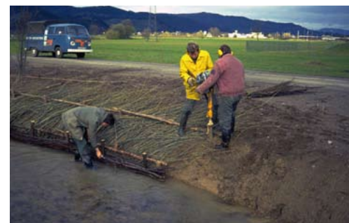
Der Einbau der Weidenspreitlagen dient der Ufersicherung. Die ineinander verzahnten Wurzelstöcke stellen eine sehr naturnahe Bauweise dar. Sie sichern das Ufer, bieten Fischen Unterstandsmöglichkeiten und können mit Erlen und Weiden hinterpflanzt werden, um einen dauerhaften Schutz zu gewährleisten.
