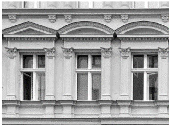
Bei der Abdeckung von Gesimsen z. B. in Stuckfassaden (siehe Abbildung) ist die Anpassungsfähigkeit von Zinkblechen besonders gefragt. In aller Regel werden diese Abdeckungen vor Ort in Zink angepasst. Eine Substitution durch vor Ort weniger leicht bearbeitbare Bleche ist technisch nur bei einfachen Profilen möglich und führt auf jeden Fall zu Mehrkosten.
