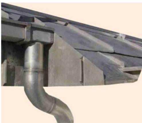
Traufbleche sind in der Regel von der Bedachung überdeckt, Einhangbleche werden vor allem dort benetzt, wo sie einen Teil der Rinne überdecken. Diese Teile des Entwässerungssystems werden deshalb vereinfachend als nicht bewitterte Blechflächen gewertet. Eine gesonderte Erfassung von Einläufen ist ebenfalls nicht erforderlich.
