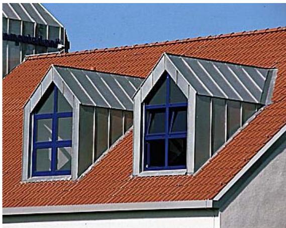
Mit der Wahl einer Blecheindeckung können die Anschlüsse an das Gebäude in den Kehlen im gleichen Material wie die Eindeckung selbst ausgeführt werden. Damit wäre ein Ersatz von Blechen mit einem erhöhten Aufwand durch zusätzliche Anschlussarbeiten verbunden.
