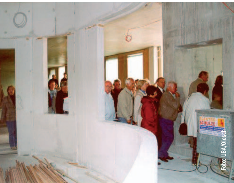
Blick hinter die Kulissen der größten Baustelle in Dessau.
