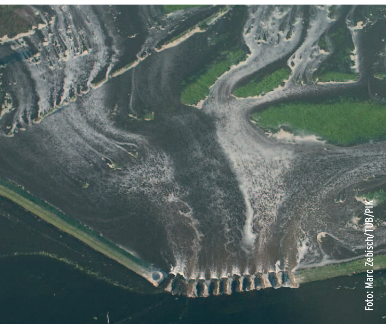
Flutung der Havelpolder während des Elbe-Hochwassers 2002.
