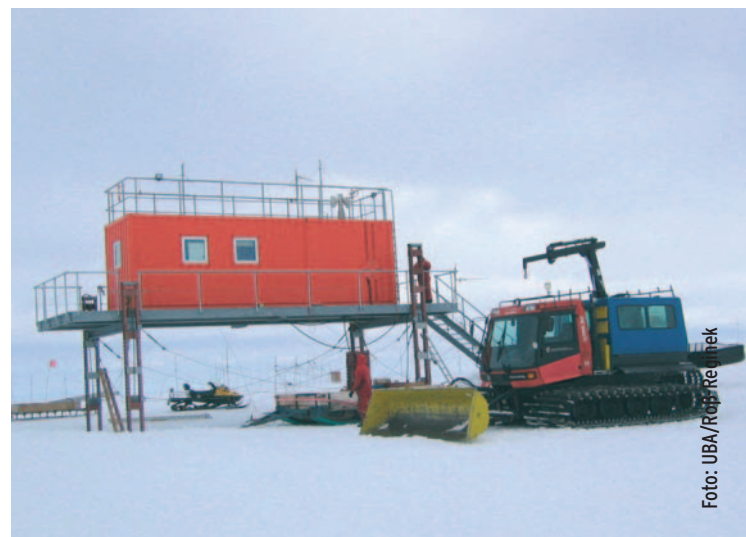
Messcontainer auf der „Neumayer III-Station“.
