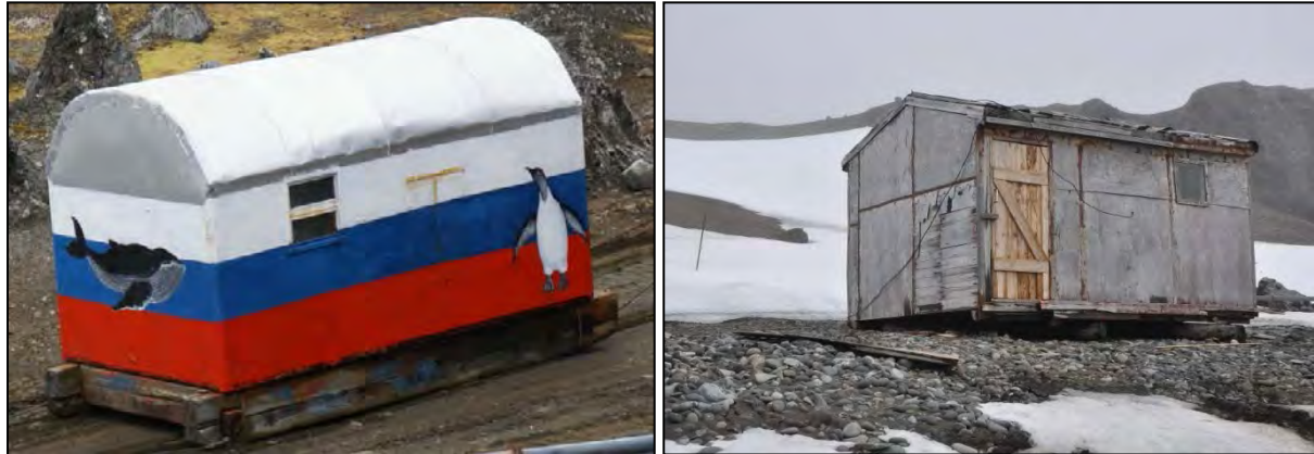
Abb. 39 a & b: a – Erneuerte und b – weitgehend ungenutzte Hütten am Großtanklager Neftebase (Fotos: A. Nordt, 15.02.2011; C. Braun, 20.01.2010).
