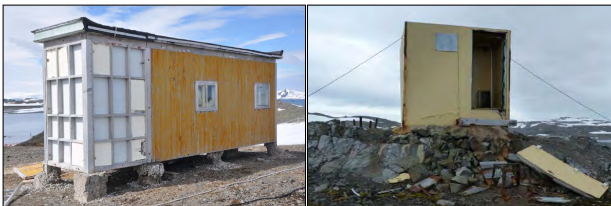
Abb. 53 a & b: Verfallende Hütten am Rand der chinesischen Station (Foto: M. Stelter, 23.01.2012).
