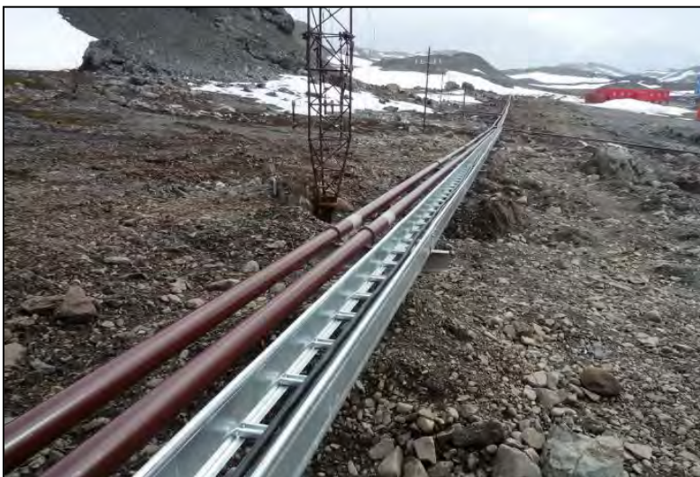
Abb. 24: Neue Treibstoffleitungen, die die Vorrattanks mit der Station verbinden (Foto: A. Nordt, 27.02.2010).
