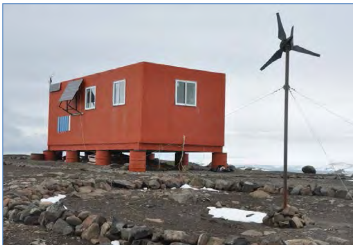
Abb. 20: Im Februar 2007 errichtete E-Base; in der Saison 2011/12 wurde die Windturbine defekt und am Boden liegend vorgefunden (Foto: C. Braun, 26.12.2009).
