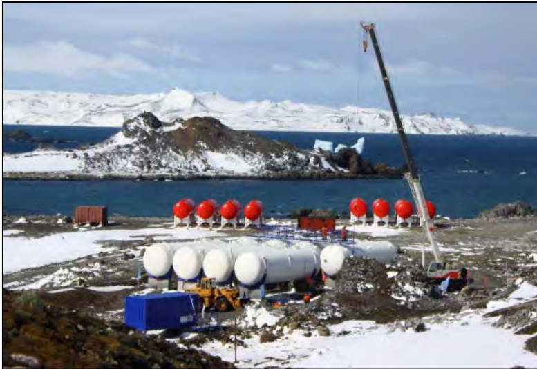
Abb. 23: In der Saison 2009/10 neu errichtete Treibstofftanks der Station Great Wall (weiß, im Vordergrund) und alte, zu ersetzende Tanks (rot, im Hintergrund; Foto: A. Nordt, 06.02.2010).
