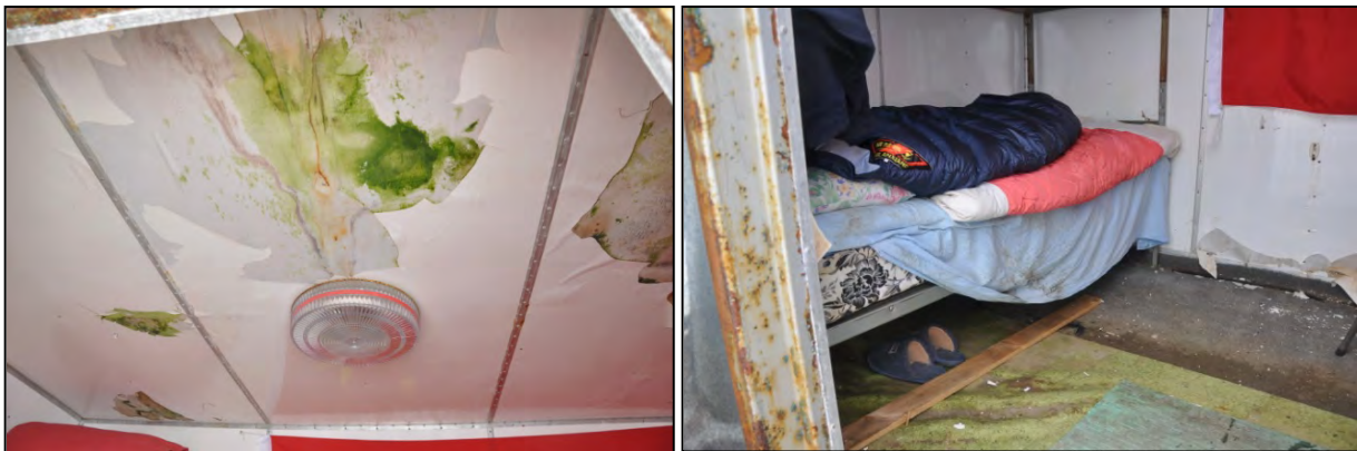
Abb. 27 a & b: Nässeschäden im Inneren des chinesischen Containers (Foto: C. Braun, 23.12.2009 (a) und 16.01.2010 (b)).
