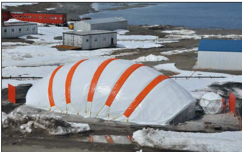
Abb. 21: Kuppelkonstruktion als temporärer Ersatz für die abgebrannte Turnhalle der Station Frei (Foto: C. Braun, 03.01.2010).
