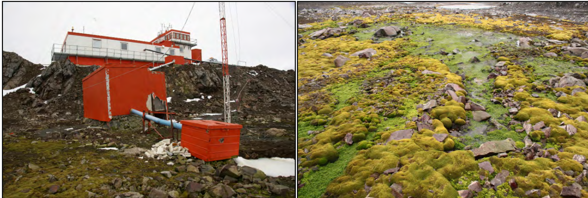
Abb. 56 a & b: Situation an der Kläranlage hinter dem Flughafentower: a – Beschädigter Klärcontainer (Foto: A. Nordt, Januar 2011); b – Auffällig starker Algen- (z. B. Prasiola crispa ) und Moosbewuchs im unmittelbaren Umfeld der Kläranlage (Foto: S. Janowski, Januar 2011).
