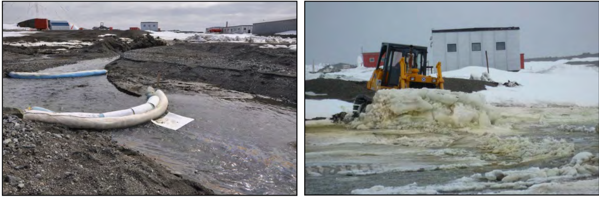
Abb. 33 a & b: a – Absorbierende Ölsperren im Mündungsbereich des Kiteshbachs, rechts im Bild ist der Ölfilm hinter den Ölsperren erkennbar (Foto: C. Braun, 31.12.2009), b – Mit Diesel kontaminierter Schnee wird am 21.12.2009 ins Meer geschoben (Foto: A. Nordt).
