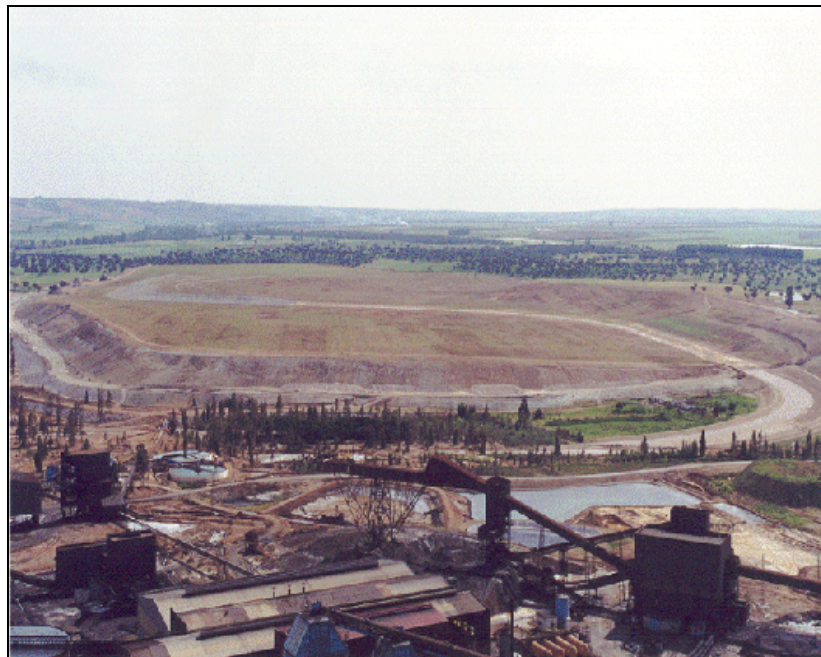
Abb. 4.8: Sammel- und Abführungskanal des geschlossenen Absetzbeckens von Apirsa
