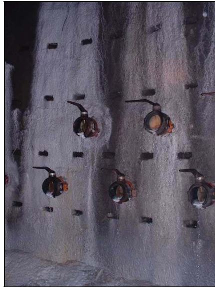
Abb. 4.25: Drainagesystem in Verfüllmaterial
