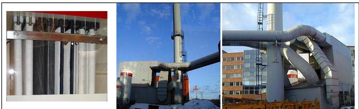
**Bild 4.10: Gewebefiltereinheiten; Innenansicht (l.) und Außenansicht (m., r.)**
